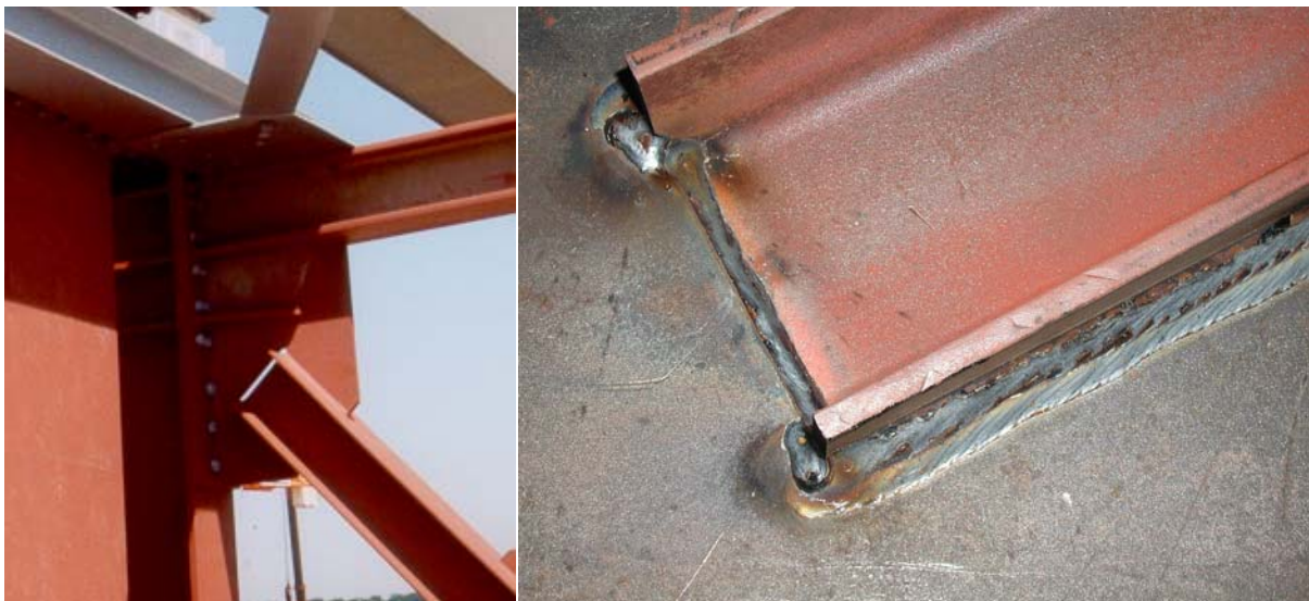
Bild 5.3 Links: Schlitz am Ende des eingesteckten Stabes zum Ausgleich von Montagetoleranzen; Rechts: Zuggeschweißter Schlitz am Stabende, dadurch undefinierter Spannungszustand
