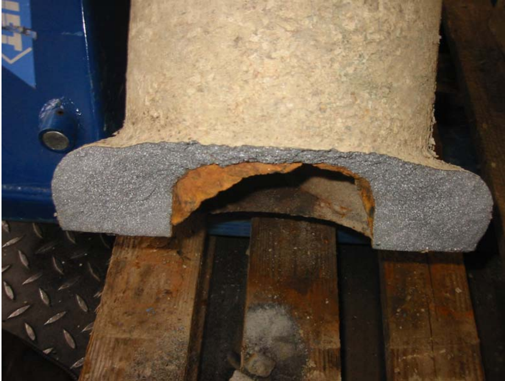
Bild 2.1 Makroskopisches Bruchbild eines Trennbruches
