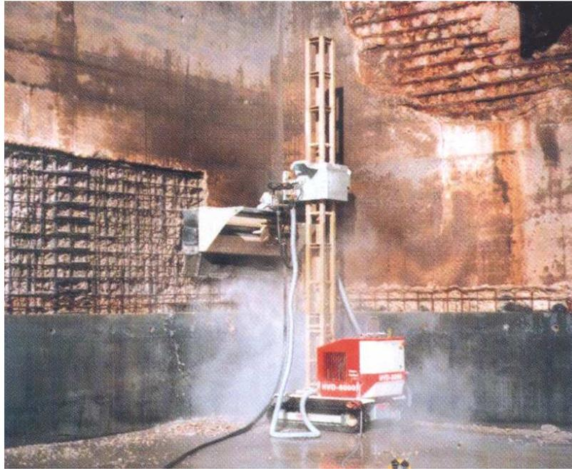
**Abbildung 7.2:** Oberflächenabtrag bis zur 1. Bewehrungslage mit Hochdruckwasserstrahlen (WOMA, 2004)
