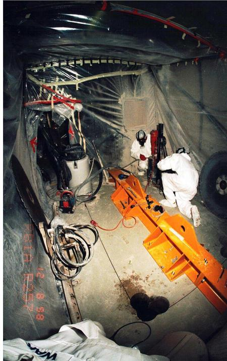
**Abbildung 7.10:** Kontaminationsschutzzelt bei Rückbauarbeiten (WAK Werkfoto)
