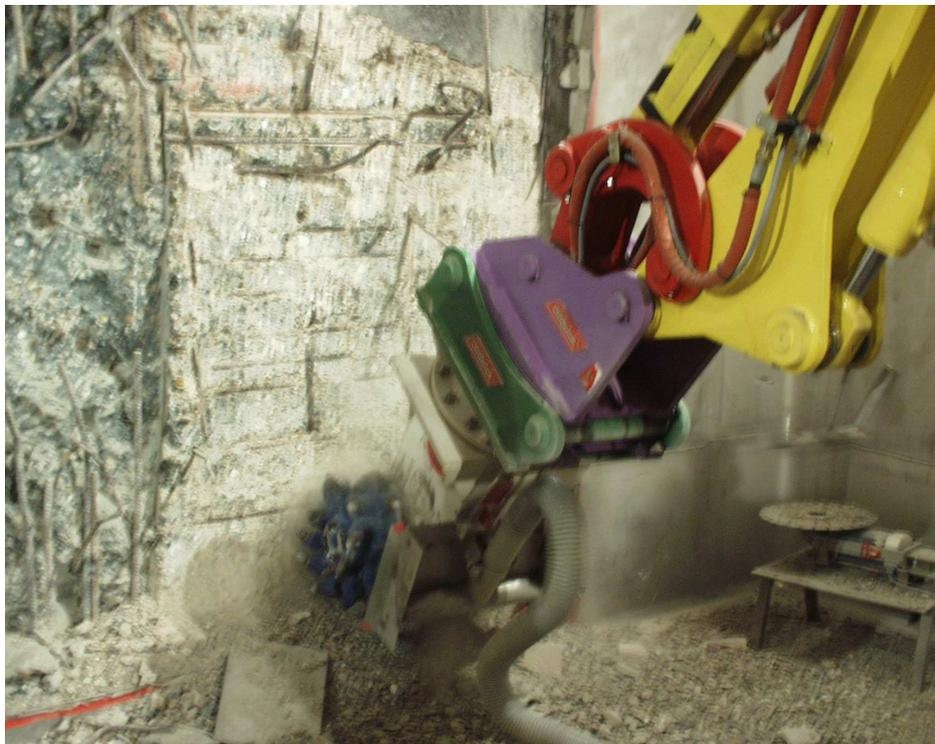
Abbildung B.2: Fräsen mit Baggeranbaufräse inklusive Staubabsaugung (WAK)
