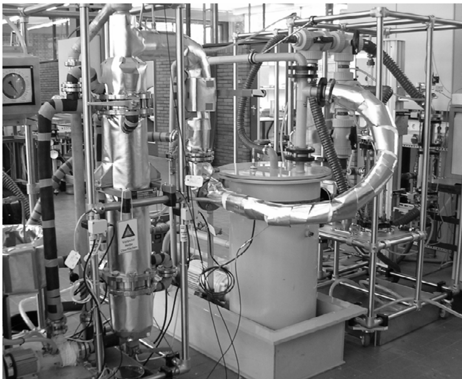
Abbildung A.23: Für den Versuch 53 wurde das mittlere Modul, in der die Flüssigkeitsring-Vakuumpumpe untergebracht ist, gegen eine Wasserstrahlpumpe ausgetauscht.
