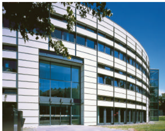
Bild 3: Das Institutsgebäude des Fraunhofer ISE in Freiburg verfügt aufgrund der unterschiedlichen Nutzung in den einzelnen Gebäudeteilen über verschiedene passive Kühlstrategien. Die externen Wärmelasten werden bei sehr guter Tageslichtausbeute durch das Fassadenkonzept reduziert.
