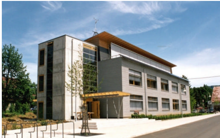
Bild 4: Im Bürohaus Lamparter in Weilheim wird der sommerliche Wärmeschutz durch effektiven Sonnenschutz, Nachtlüftung und Erdwärmetauscher in das Passivhauskonzept einbezogen.
