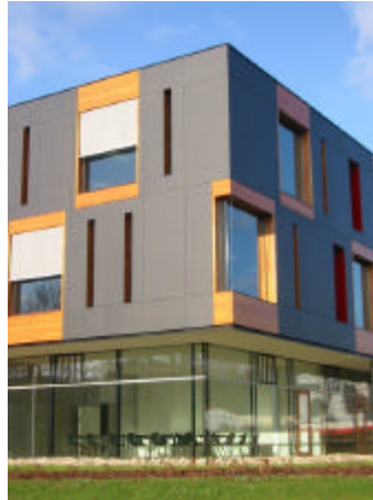
Bild 2: Das Verwaltungsgebäude der Pollmeier Massivholz GmbH ist ein weitgehend natürlich belüftetes Bürogebäude ohne aktive Klimatisierung.
