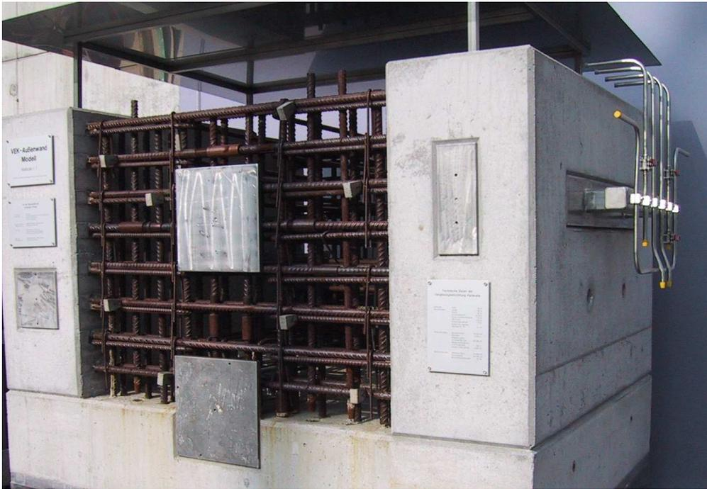
**Abbildung 6.4:** Darstellung typischer Bewehrungsdurchmesser und Einbauteile am Beispiel des VEK Außenwandmodells
