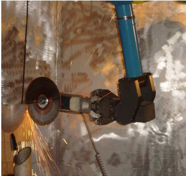
**Abbildung B.5:** Trennschleifer elektrisch geführt mit Manipulator (WAK)
