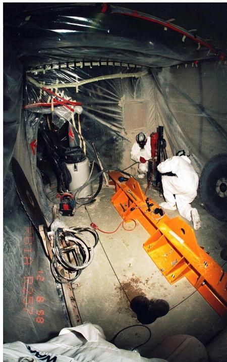
Abbildung 7.10: Kontaminationsschutzzelt bei Rückbauarbeiten (WAK Werkfoto)
