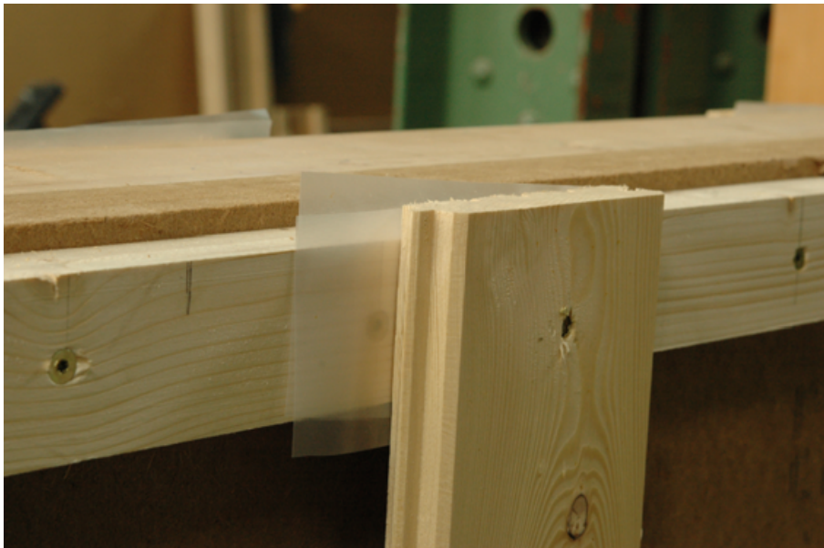
Bild 8-13 Anschluss der NF-Schalung (Vertikalstäbe) an Konterlatte (Horizontalträger)
