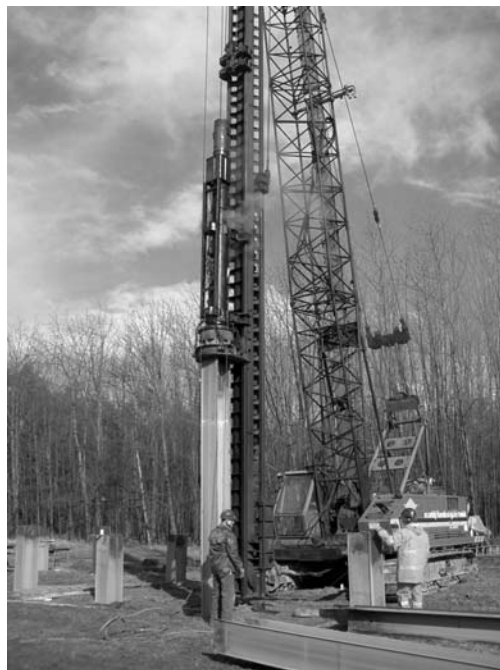
Abbildung 6.23: DELMAG D12-32 an Seilbagger
