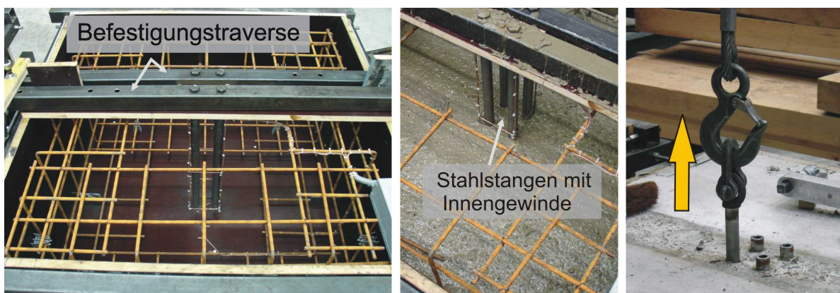
Bild 5.7: Stahlstangen und Ziehen der Stangen
