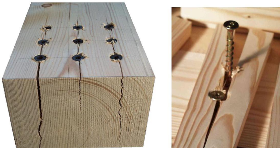
Abbildung 1: Rissbildung und Aufspalten beim Einschrauben aufgrund geringer Abstände bzw. Holzdicken
