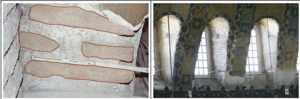
Abb. 4.49: (a) Mauerwerk des 6. Jahrhunderts (Rippe 9) (b) Mauerwerk des 10. Jahrhunderts (Rippe 23)
