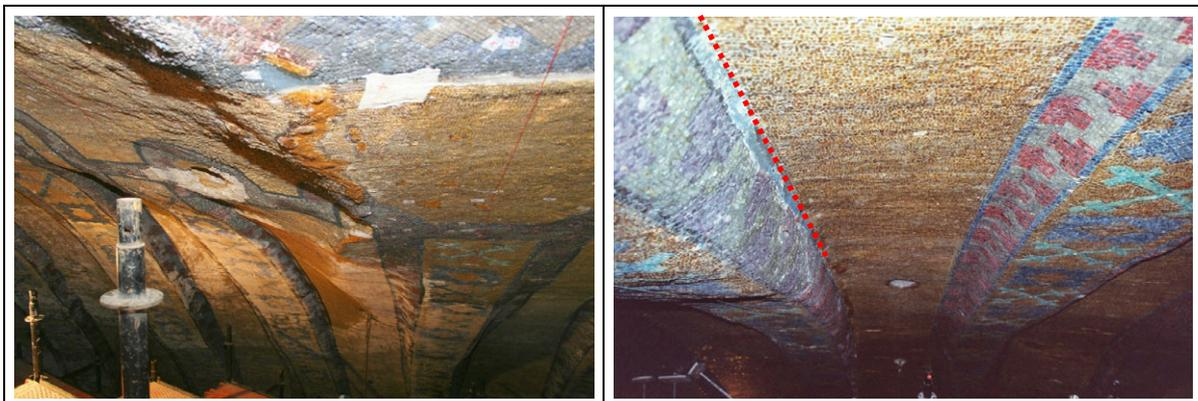
Abb. 4.40: (a) Bruchkante zwischen den Bauteilen des 14. und 6. Jahrhunderts
