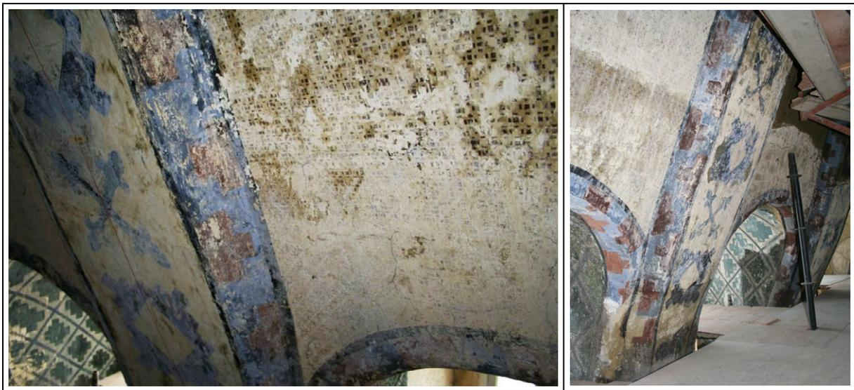
Abb. 4.58: (a) Feuchteschäden im Bereich der Rippe 5
