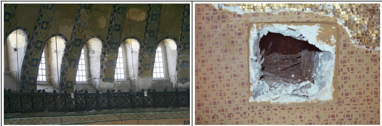
**Abb. 4.64:** (a) Fensterpfeiler mit den Durchdringungen eines ehemaligen hölzernen Ringankers (b) Detailaufnahme der Durchdringung
