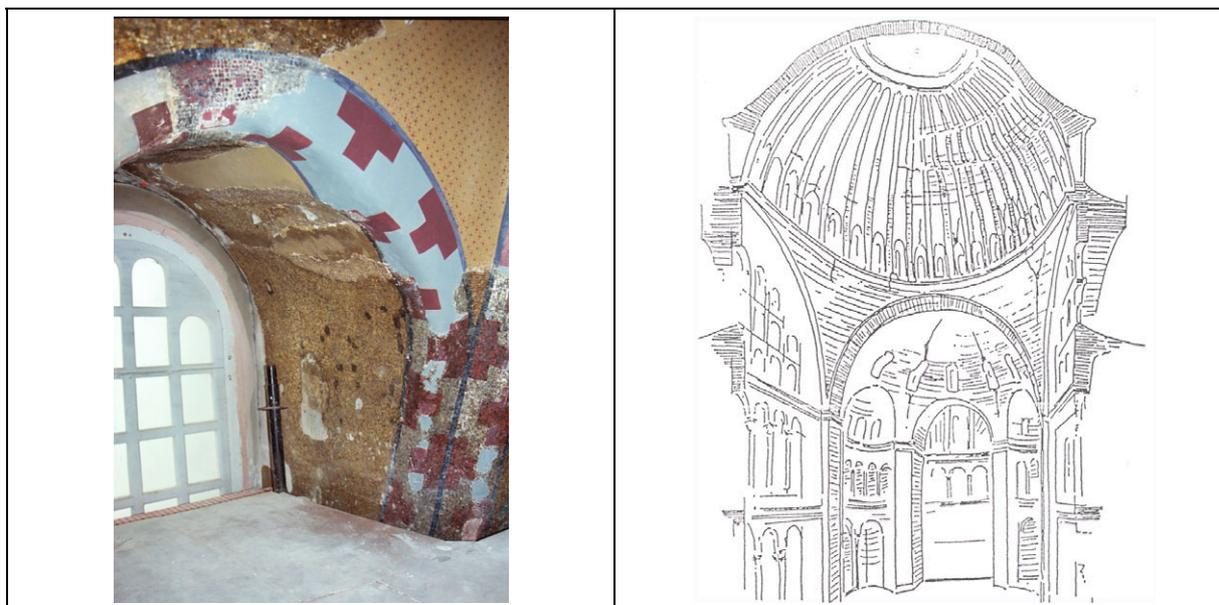
**Abb. 10.34:** (a) Sanierte horizontale Risse im Kämpfer- und Scheitelbereich des Fenstergewölbes bei Rippe 19
