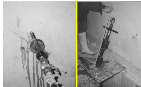
Abb. 18: Spezielles Packersystem zur Überprüfung der „Wassergängigkeit“ von Rissen im Bauteilinneren
