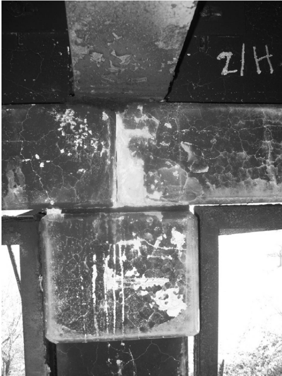
Abb. 48: Beschaffenheit der Betonoberfläche im Bereich des Brandherds. Ein Netz von feinen Rissen an der Bauteiloberfläche und niedrige Rückprallwerte deuteten auf Gefügestörungen im Beton hin
