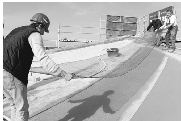
Abb. 16: Auflegen einer Lage textiler Bewehrung aus Kohlefaser auf eine frische, gesprühte Mörtelschicht
