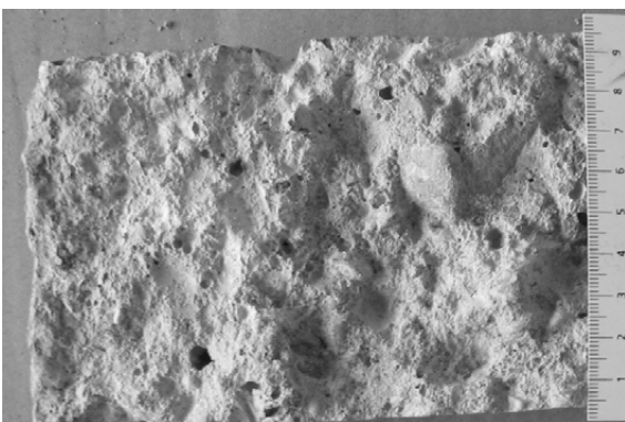
Abb. 25: Untersuchungen am Bohrkern: Rissfläche umläuft die großen Gesteinskörner des Zuschlaggemisches
