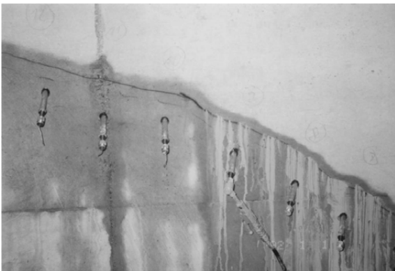
Abb. 20: Erkundungs- bzw. Probeinjektionen zur Ermittlung weiterer Informationen zur Rissbeschaffenheit
