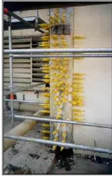
Abb. 2: Injektion von Rissen mit Federdruckinjektoren
