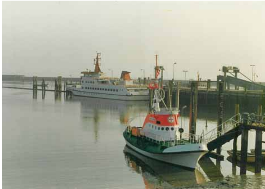
Abbildung 268: Der neue Anleger mit Hubbrücke und neuem Fahrgastschiff.
