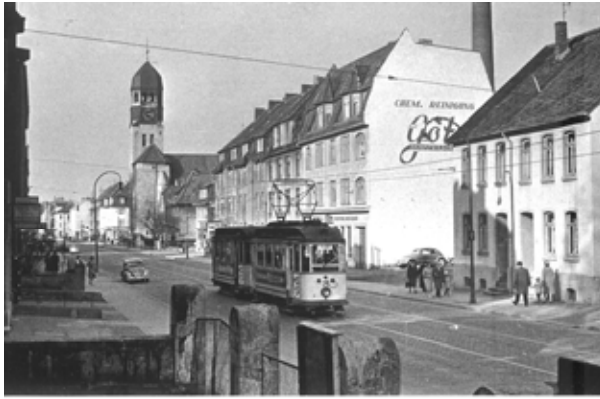
203 Ein Zug mit Triebwagen 26 aus Richtung Haste in der Iburger Strasse kurz vor dem Tivoli mit Blick auf die Lutherkirche im Hintergrund. (Foto A. Spühr, 6. 3. 1960)
