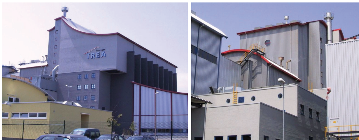
Abbildung 11: Außenansicht der TREA Breisgau.
