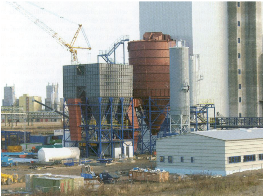
Abbildung 8: Bau der Rauchgasreinigung an der TREA Leuna [NN].
