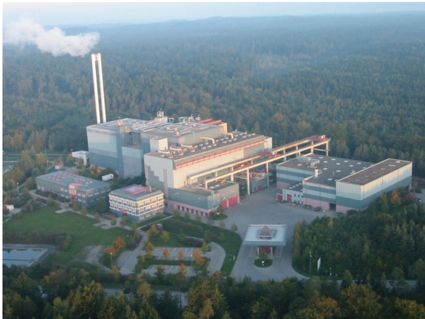
Abbildung 14: Ansicht des MHKW Burgkirchen [LFU_1].
