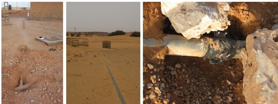
Abbildung 4.7: Leitungen des Wasserverteilungssystems (linkes Bild: C. Laures)
