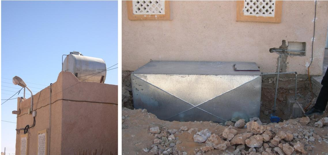
Abbildung 4.4: Auf dem Dach (*links*) und ebenerdig (*rechts*) angeordnete Hausbehälter (J. Deuerlein)
