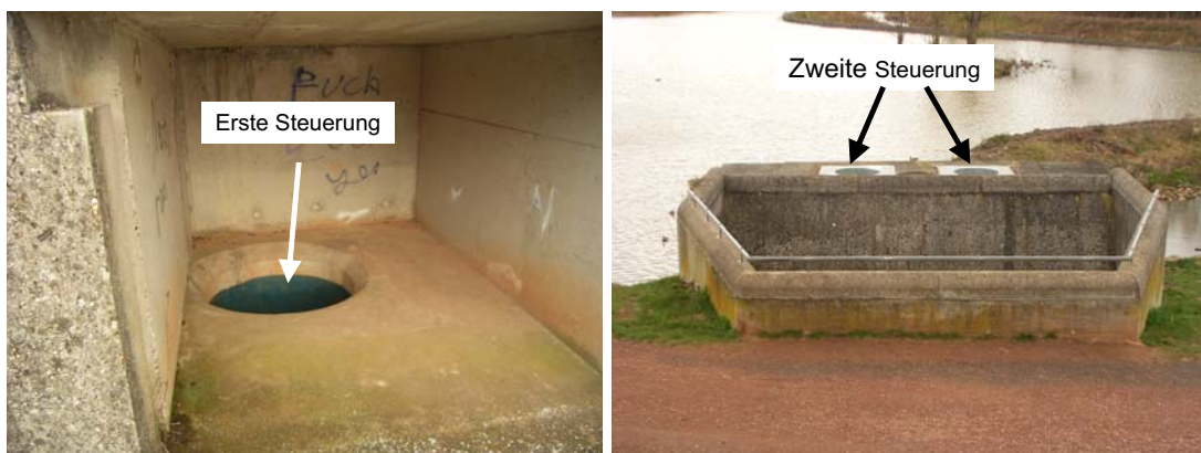
Abbildung 2.18: HRB Alzey, Anordnung und Ausführung der ersten und zweiten Steuerung.
