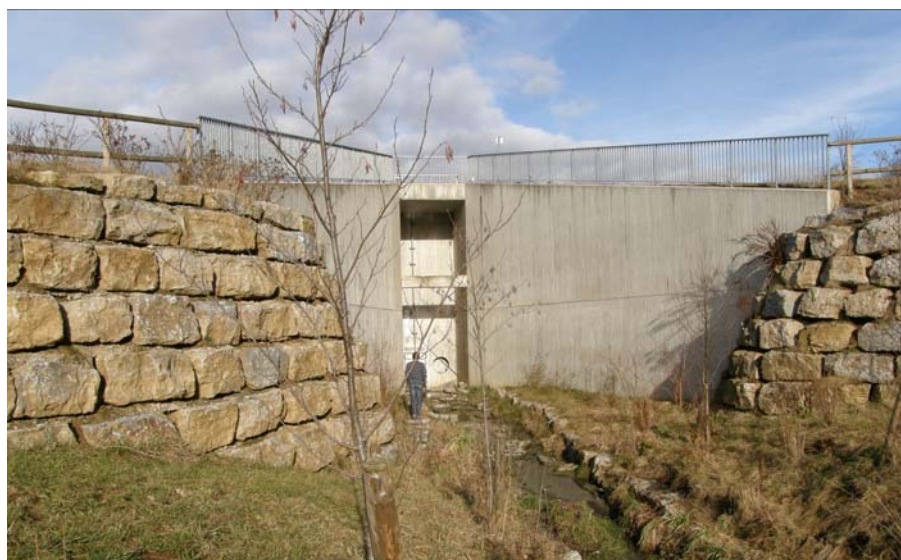
Abbildung 5.11: Blick von Unterstrom auf das Durchlassbauwerk des HRB Apfelbach
