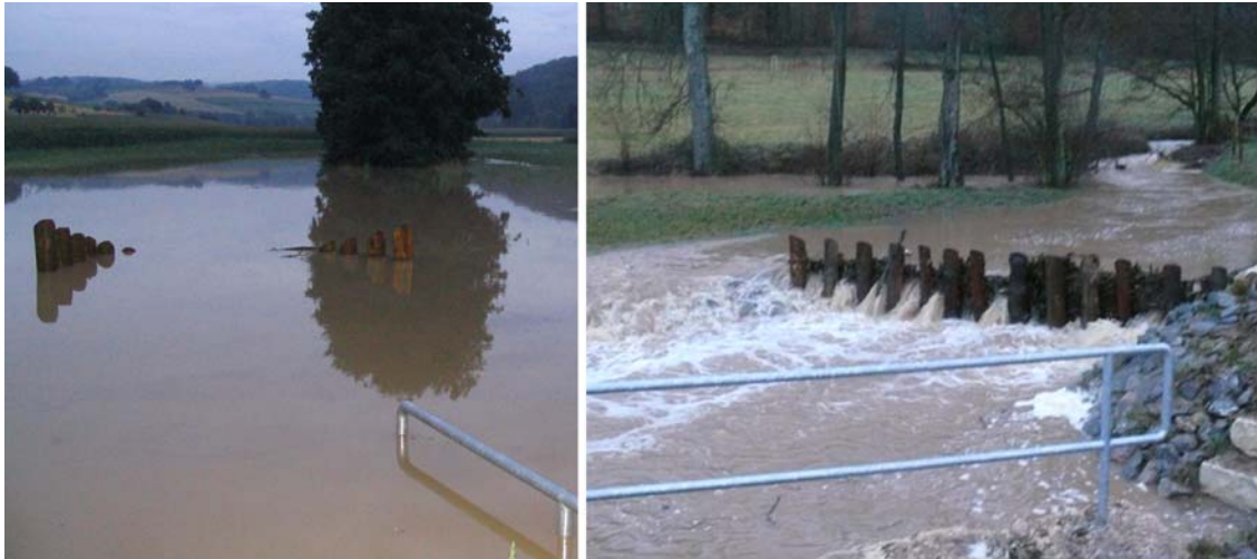
Abbildung 5.8: Palisaden während eines Hochwasserereignisses, HRB Insenbach (links), HRB Oberschwarzenbach (rechts) [128].
