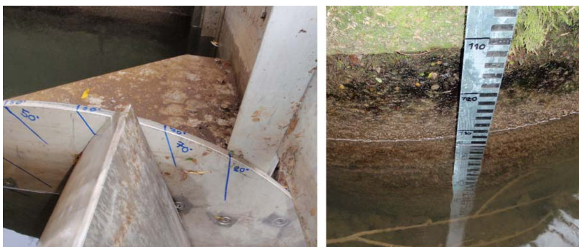
Abbildung 7.9: Eingesetzte Messtechnik für die hydraulische Überprüfung
