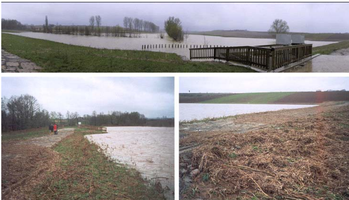
Abbildung 5.6: Geschwemmselanfall HRB Raußmühle beim Schadensfall im März 2002 [128].
