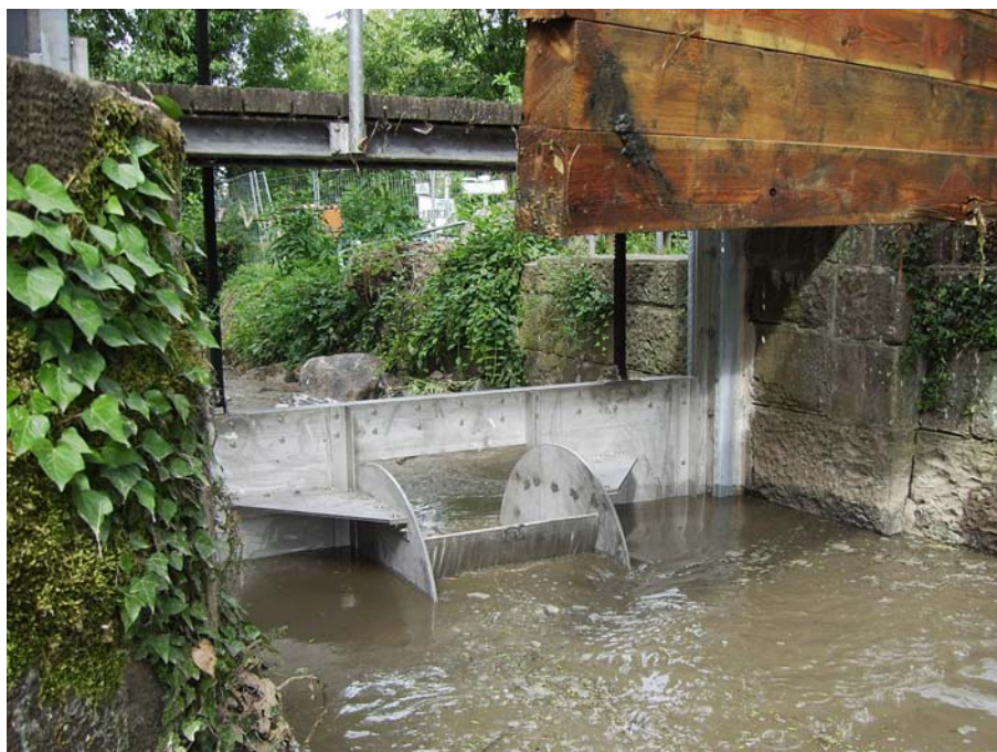
Abbildung D.17: Die Dammbalken der Baustellenabdichtung werden gezogen
