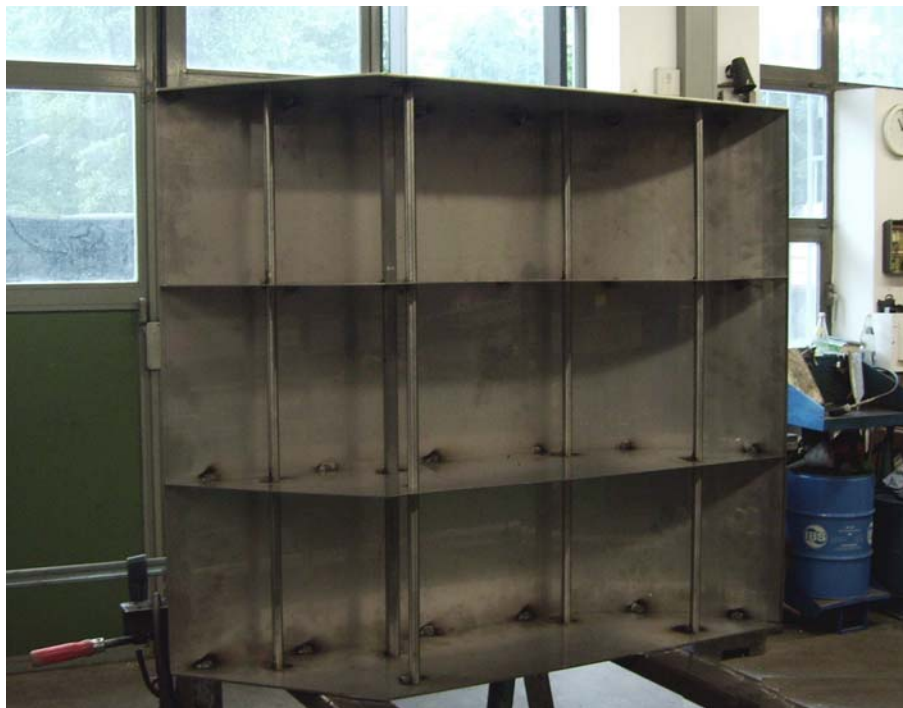
Abbildung D.6: Aufschweißen der Bepunktung auf das Rippenskelett
