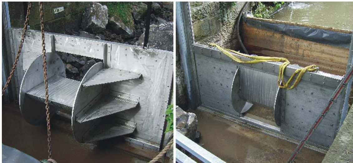
Abbildung 7.8: Schützmodul mit Schwingklappe beim Einbau
