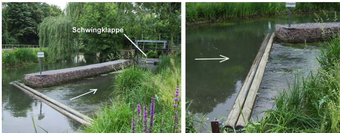
Abbildung 7.19: Schwimmbalken vor dem Zulaufbereich der Schwingklappe
