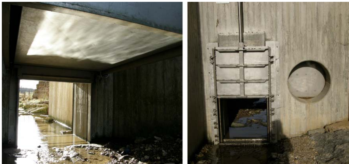
Abbildung 2.11: HRB Apfelbach, Blick auf die Schwimmerunterkante (links), redundanter Schieber des Betriebsauslasses an der Unterwasserseite der Stauwand (rechts).
