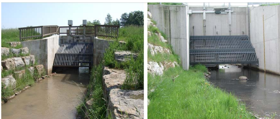
Abbildung 5.10: Räumlicher Feinrechen, HRB Raußmühle (links), HRB Möchzell (rechts).
