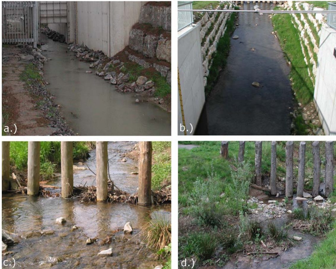
Abbildung 4.58: Sohlbeschaffenheit verschiedener HRB im Einzugsbegebiet Elsenz-Schwarzbach: a.) HRB Gemmingen, b.) HRB Mönchzell, c.) HRB Waldwimmersbach-Lobbach, d.) HRB Spechbach
