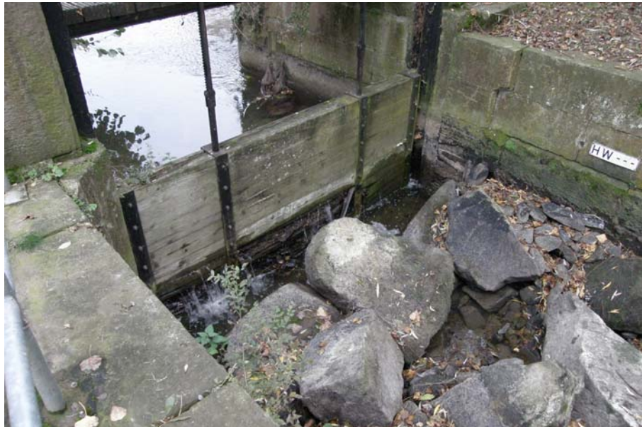
Abbildung D.2: Altes Holzschütz am Einlauf der FAA vor Einbau der Schwingklappe, Blick von Untertrom
