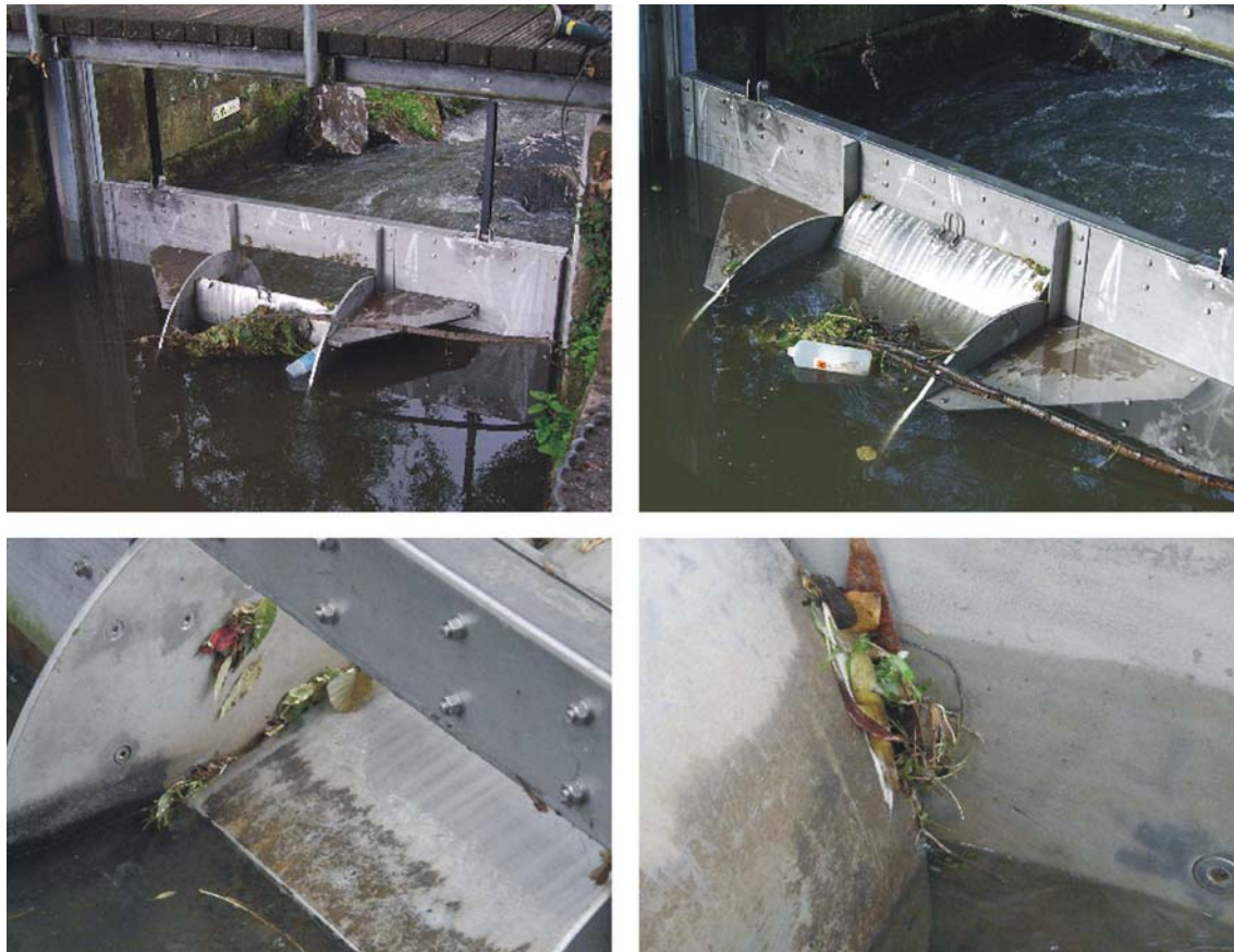
Abbildung 7.20: Geschwemmsel an der Schwingklappe
