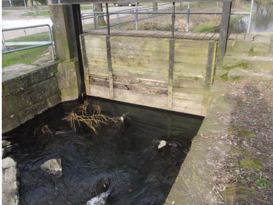
Abbildung D.1: Altes Holzschütz am Einlauf der FAA vor Einbau der Schwingklappe, Blick von Untertrom
