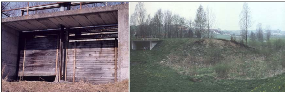
Abbildung 4.50: Verklebtes Schütz, HRB Haslach, [Foto: Bernhart]
