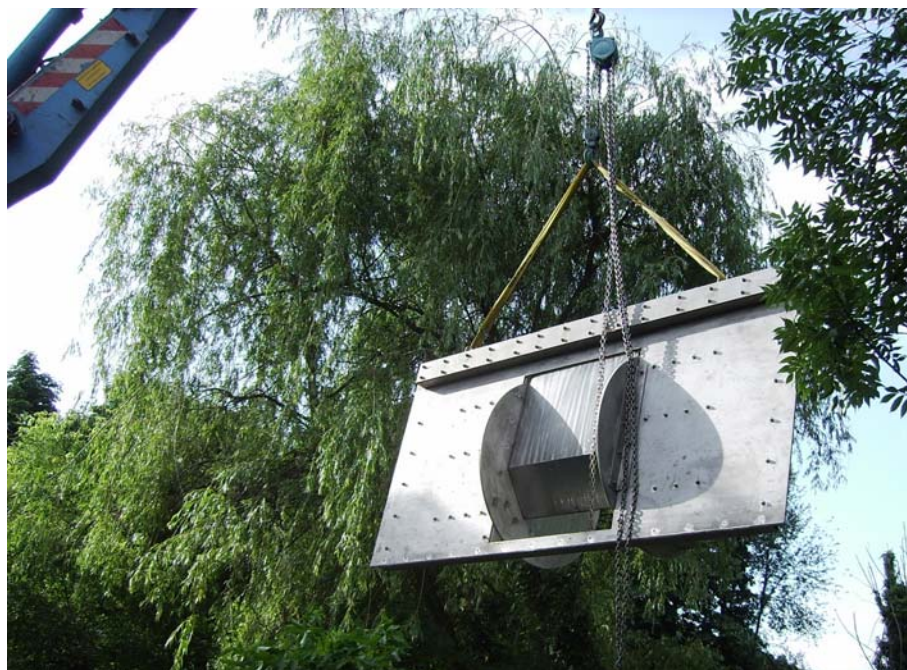
Abbildung D.11: Einbringen des Schützes mit integrierter Schwingklappe
