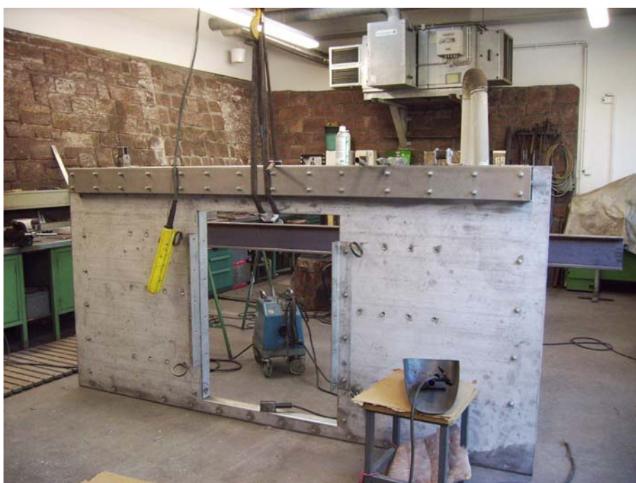
Abbildung D.8: Rohbau des neuen Edelstahlschützes
