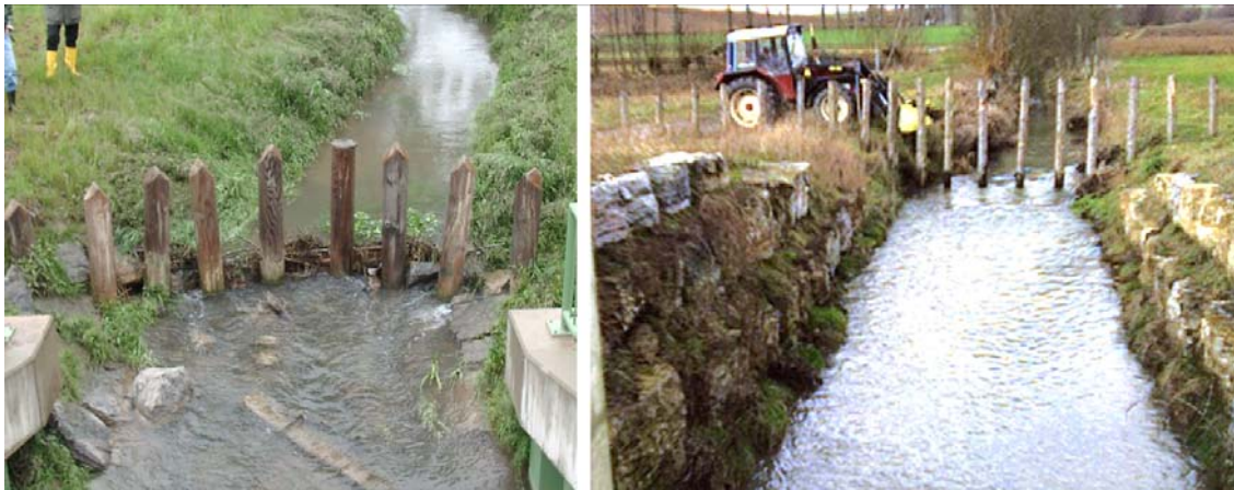
Abbildung 5.9: Verklausung der Palisaden bei Niedrigwasser (links), Ausräumen per Traktor (rechts) [128].
