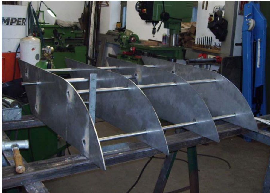
Abbildung D.5: Montage der Rippen mit Führungsschienen
