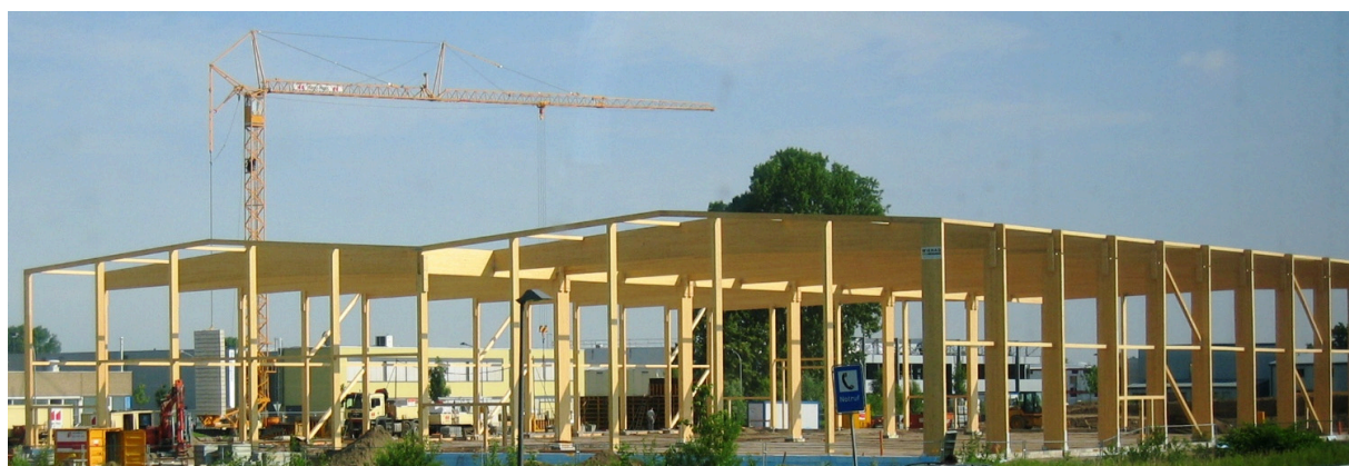
Bild 3-1 Kritische Bauphase: Die Konstruktion aus Brettschichtholz ist ohne schützende Hülle der Witterung ausgesetzt
