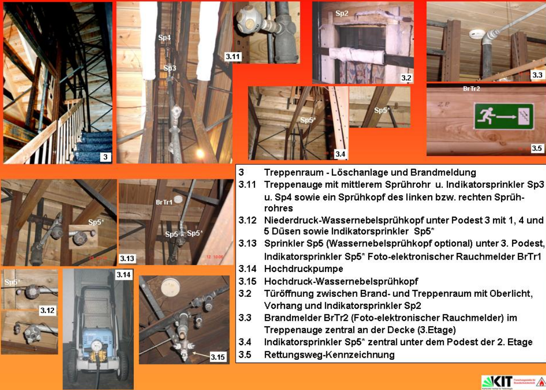
Bild 25: Versuchsholzgebäude mit Brand- und Treppenraum (FFB) - 2
