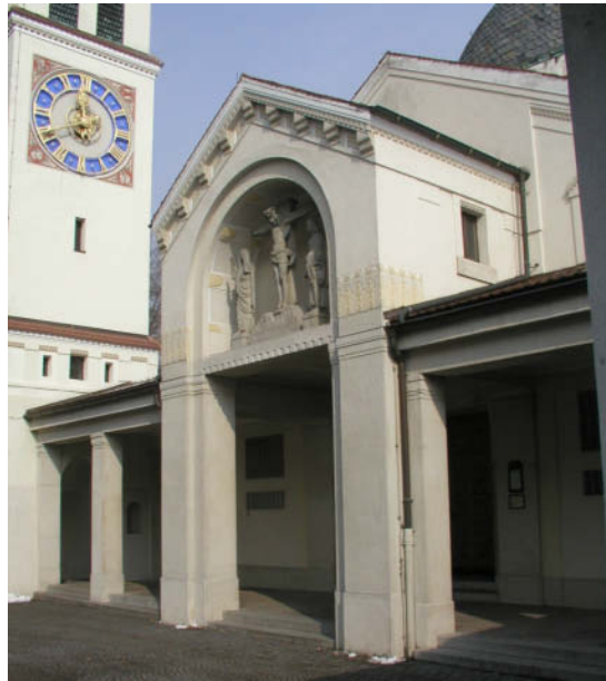
Abb. 8: Sanierte Partien am Portal der Aussegnungshalle, im Hintergrund der Glockenturm
