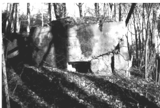
Abb. 21: Karlsruhe, gesprengter Westwallbunker
