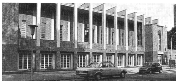
Abb. 4: Karlsruhe, Tribüne des Hochschulstadions
