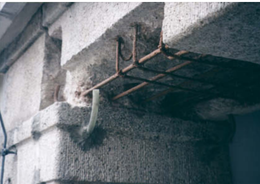
Abb. 7: Balkenträgerauflager auf Arkadenstütze Sanierungsschritte (unter Beachtung der DAfStb-Richtlinie):
