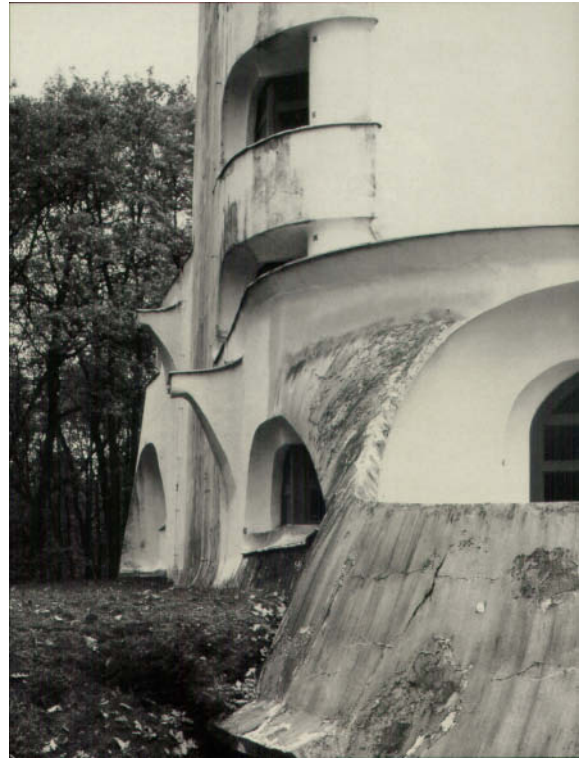
Abb. 5: Sanierung: Werkstatt für Denkmalpflege Pitz und Hoh, Berlin, Ingenieurbüro Gerhard Pichler, Berlin
