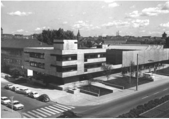
Abb. 9: Gesamtansicht der Norishalle
