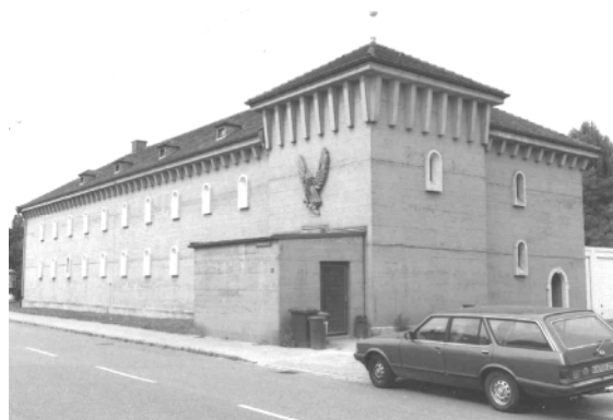
Abb. 20: Karlsruhe, Luftschutzbunker in Daxlanden
