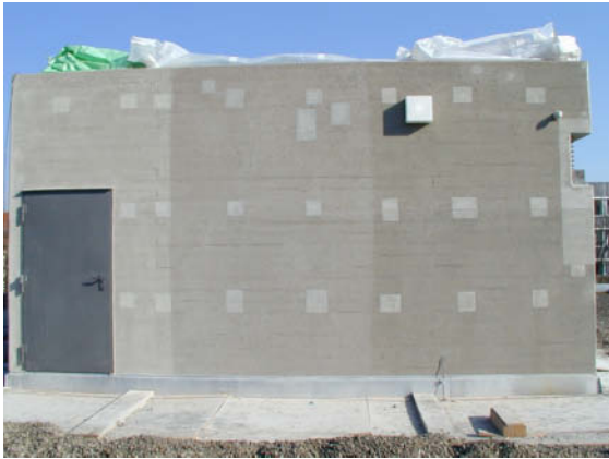
Abb. 22: Westseite des Aufzugskopfes
