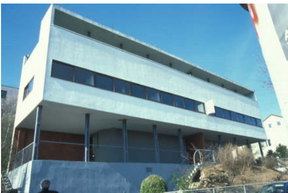
Abb. 1: Sanierung: Architekten 109 Arnold + Fentzloff Stuttgart, Büro für Baukonstruktionen Karlsruhe
