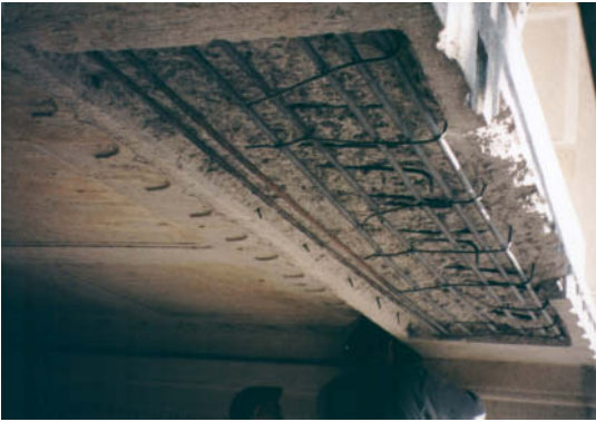
Abb. 6: Träger für die Lastaufnahme der Kreuzigungsgruppe im Portalbogen eingestellt
