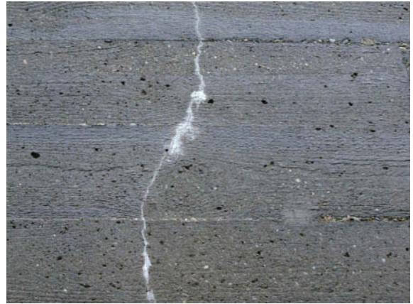
Abb. 17: [G] Feine trockene Risse
