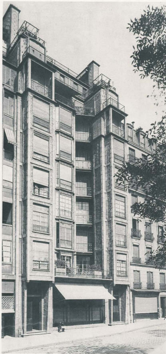
Abb. 5: Paris, rue Franklin 25 (1903–04). Das Büro der Baufirma „Perret frères“ befand sich 1903-29 im Erdgeschoß des Hauses. Hier arbeitete der junge Charles-Eduard Jeanneret, der sich später Le Corbusier nannte, von Februar 1908 bis April 1909. Hier lernte er die ungeahnten Möglichkeiten des Eisenbetons kennen, die seine eigenen Architekturkonzepte entscheidend prägen sollten
