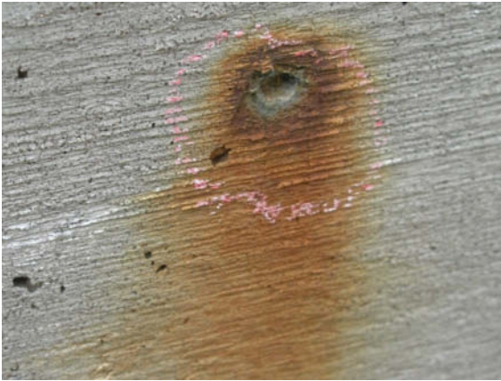
Abb. 20: [L] Zuschläge – mit Rostfahnen
