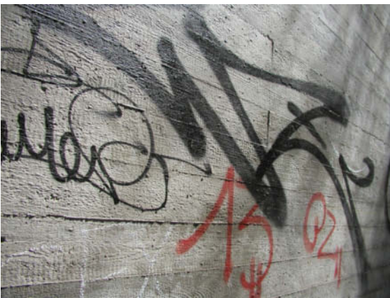
Abb. 21: [M] Graffiti – Teils noch nicht entfernt. Teils entfernt, jedoch Farbreste und Bearbeitungsspuren.
