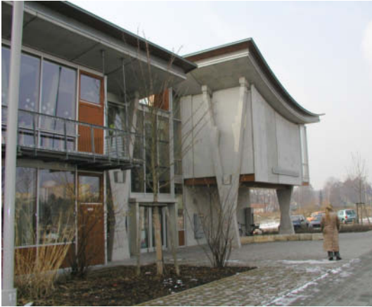
Abb. 24 Eingangssituation des Schulkomplexes Röthenbach Ost. Hochbauamt 09/2000
