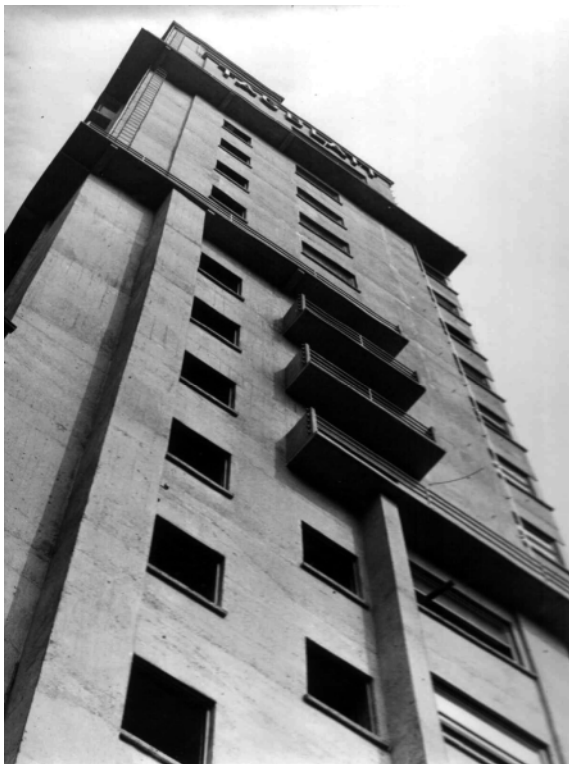
Abb. 14: Fassade mit Rettungsbalkonen
