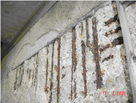
Abb. 2: Theodor-Heuß-Brücke Wiederlager Ost
