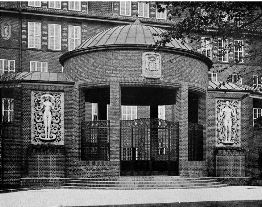
Eingang (Wasmuths Monatshefte für Baukunst 1919, S. 263)
