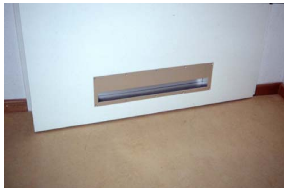
Bild 4-4 Überströmöffnung im Türblatt [Schulze Darup, 2008]
