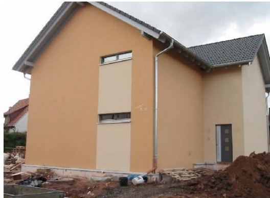
Bild 7-6 Nordseite eines Passivhauses [www.passivhaus-info.de]
