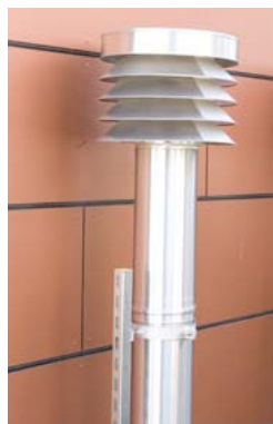
Bild 7-8 Einlass einer Lüftungsanlage [www.architec24.de]
