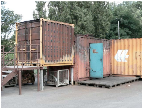
Anhang 6 Bild 1 Brandübungsanlage der Feuerwehr Karlsruhe
