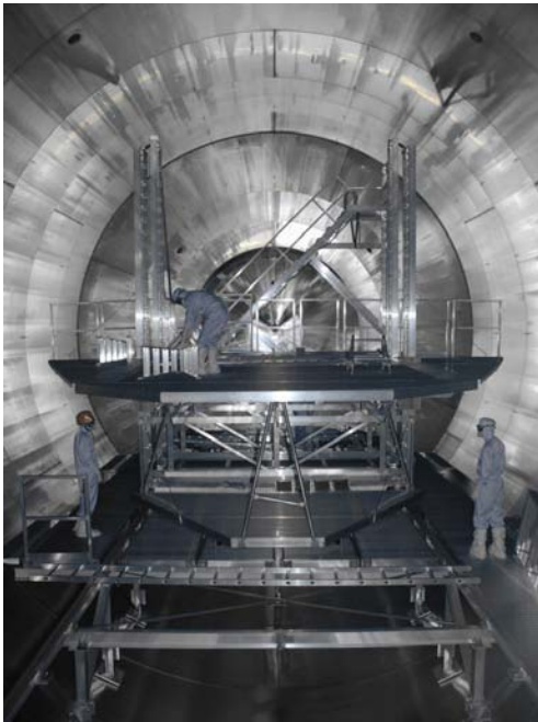
(a) Gerüstsystem im Inneren von KATRIN
