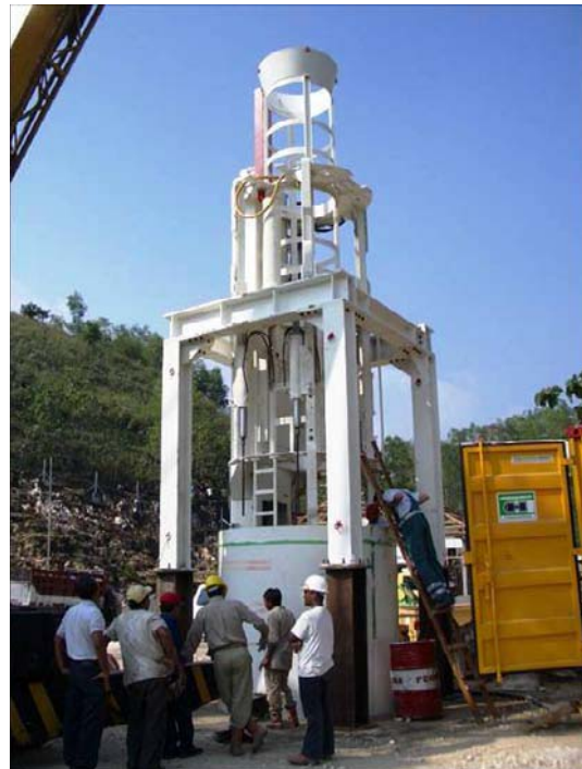
Abb. 3-4: Vertikalbohrmaschine der Firma Herrenknecht AG
