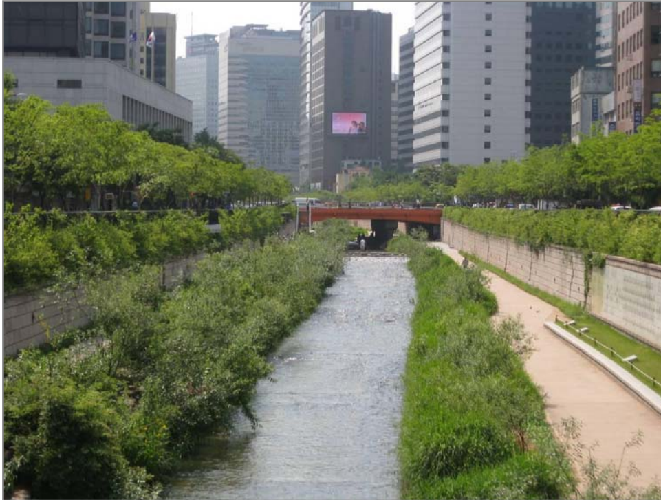
Abbildung 34: Verbaute Ufer mit einem Gehölzstreifen an der Böschungsoberkante am Cheonggyecheon in Seoul (FRISKE 2009).
