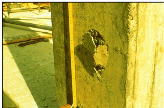
Abb. 1: Betonschaden durch Kalktreiben (Auslöser: verunreinigte Gesteinskörnung)
