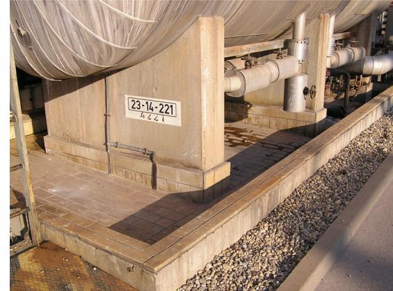
Abb. 5: Säurefeste Auskleidung mit Keramikfliesen
