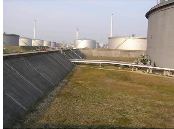
Abb. 4: Betonplatten auf Tankwällen
