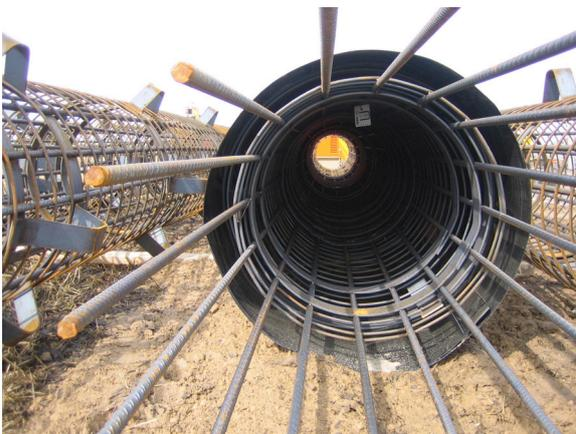
Abb. 6: Hüllrohr als Schutzmaßnahme
