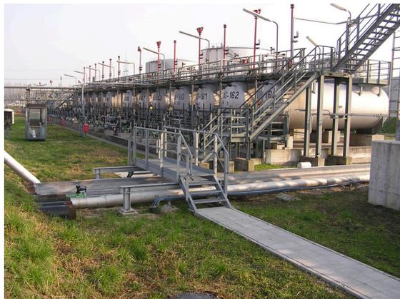
Abb. 3: Lagerbehälter für Additive mit Pumpen
