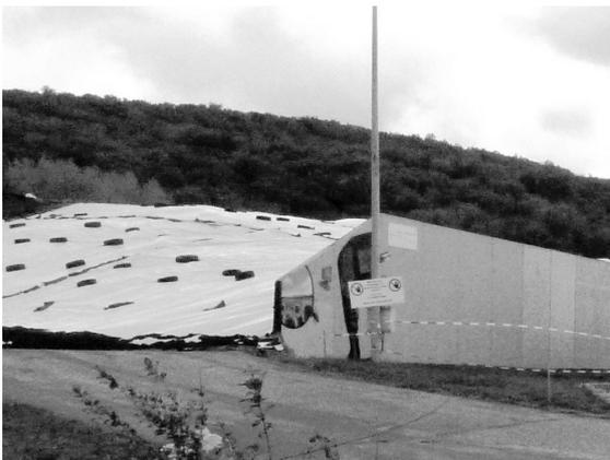
Abb. 1: Fahrsilo mit Ortbetonbodenplatten und eingespannten Fertigteilwänden
