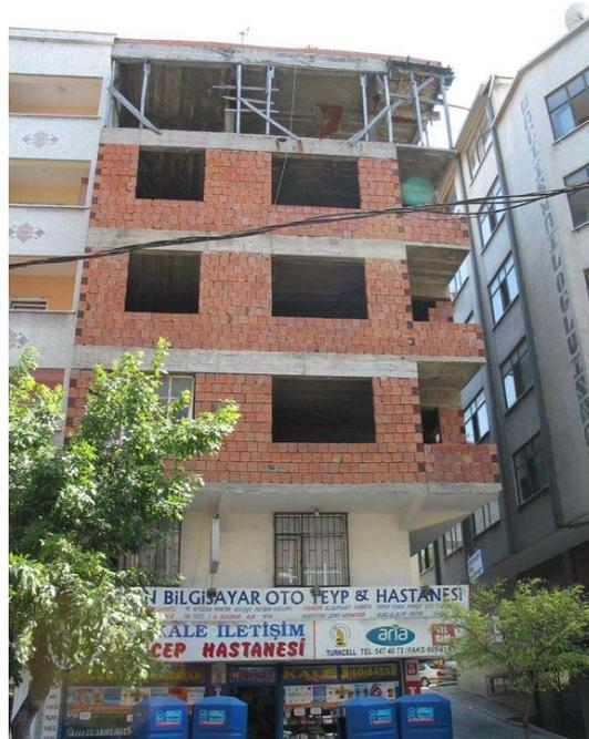
**Abbildung 2.6: Rahmenkonstruktion mit Mauerwerksschubwänden in Istanbul**
