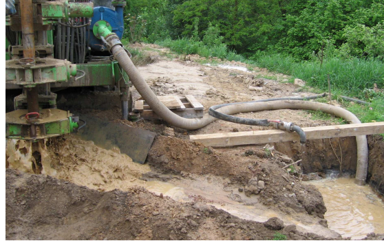
Abb. 7-1 Links: Ableitung des Schlammwassers aus dem Aushubsammelcontainer auf ein Feld; Bohrvorhaben #21. Rechts: Auffanggrube zur Sammlung des Schwemmwassers bei einer Geothermiebohrung; Bohrvorhaben #1.
