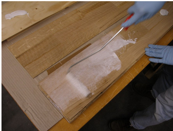
(a) Auftragen und Verteilen des Leimes auf dem Parkett mit einer Malerrolle.
