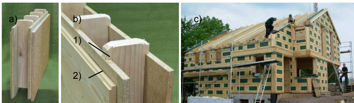
Bild 2-3 Elementbauweise: a) Einzelement, b) Details 1) Überstand Steg, 2) Überstand Beplankung, c) Rohbau in Einzelement-Bauweise
