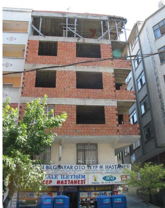
Abbildung 2.6: Rahmenkonstruktion mit Mauerwerksschubwänden in Istanbul
