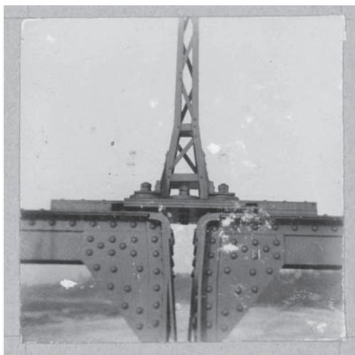
113 Brückenbremse mit Mast, 1893
