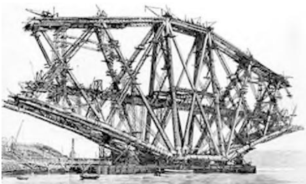
Abbildung 37 Konstruktion der Forth-Brücke. 63
