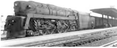
Abbildung 13 Mightiest machine ever? Eine T1 Duplex-Maschine der Pennsylvania Railroad, Dayton, Ohio, 1948. 23
