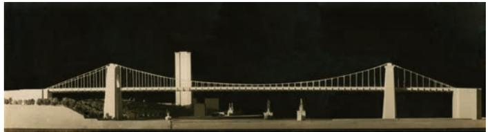
C) Entwurf MAN/Härter für die Elbehochbrücke in Hamburg 1937, Aufnahme des bauzeitlichen Modells
