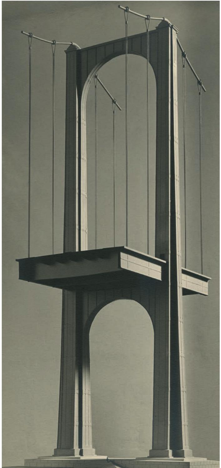
J) Gegenentwurf Fritz Leonhardts für den Pylon der Elbe-Hochbrücke in Hamburg in Stahl 1939, Aufnahme des bauzeitlichen Modells
