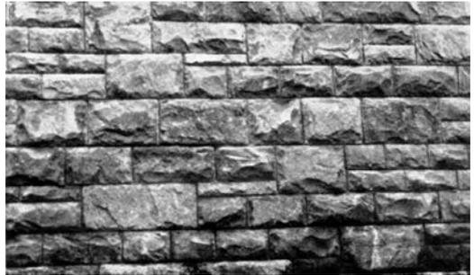
E) F) Regelmäßiges Schichtmauerwerk und unregelmäßiges Schichtmauerwerk, gebost
