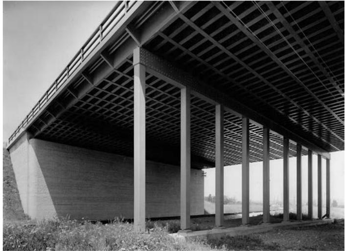
J) Vermutlich Autobahnunterführung bei Kirchheim u. Teck, von Leonhardt fälschlicherweise beschriftet »Wegüberführung Jungingen bei Ulm. Stahlzellenbauweise«, handschriftlich später »1935. Entwurf Leo[nhardt] + Schae[chterle]« hinzugefügt
