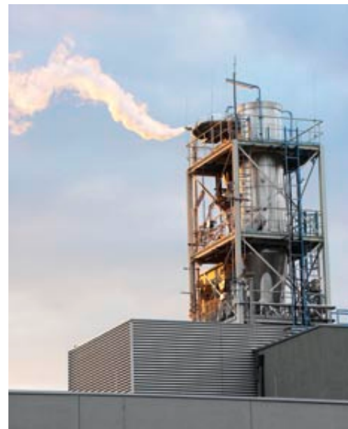
Alternative auf dem Prüfstand: In Anlagen am KIT testen Forscher, ob biogene Reststoffe fossile Energieträger ersetzen können.
