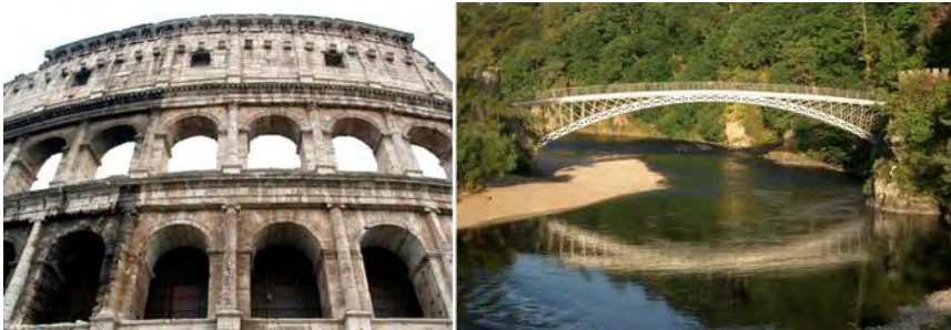
Bild 6 Links: Mächtige Bögen beim Kolosseum in Rom (Foto: Sylke Scholz); rechts: Fachwerkbrücke von Telford bei Craigellachie
