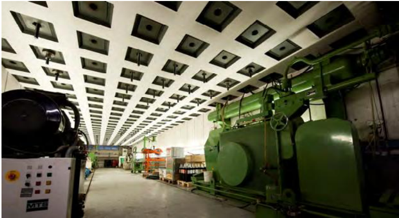
Bild 5 Untersicht des Aufspannfeldes der Versuchshalle
