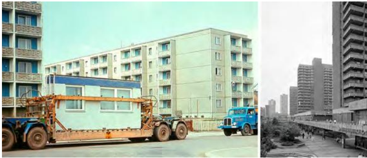
Bild 2 Plattenbauweise (Fotos: Eugen Nosko (links), Joachim F. Thurn (rechts) [3])
