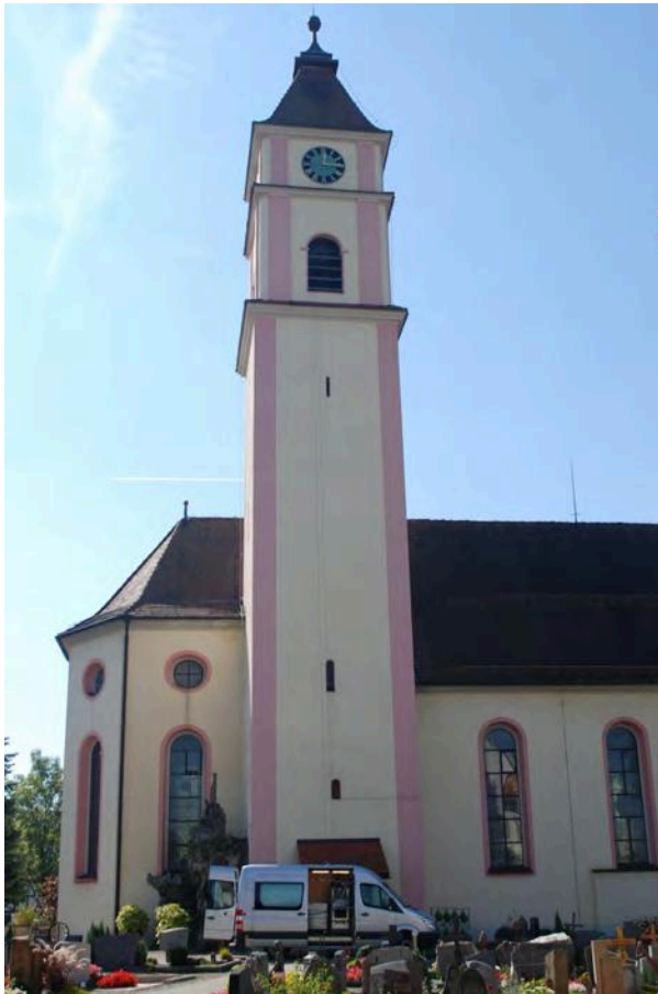
Bild 1 Schwingungsmessung am Kirchturm von St. Johannes in Obereschach mit Hilfe des mobilen Messlabors
