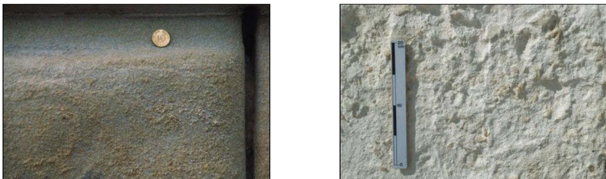
Abb. 2.25: Absanden (links) und Abmehlen (rechts) in Sandsteinen, Bildbreite links ca. 30 cm, rechts ca. 45 cm [44]
