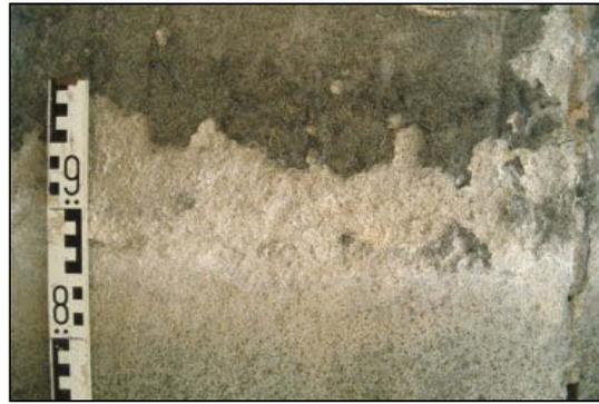
Abb. 2.27: Abtrennen einer Kruste mit anhaftendem Gesteinsmaterial [44]
