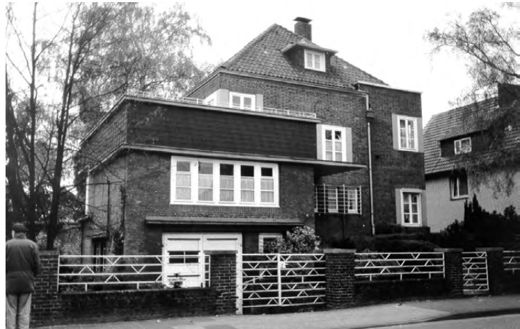
Abb. 90 Ansicht Paderborner Straße
