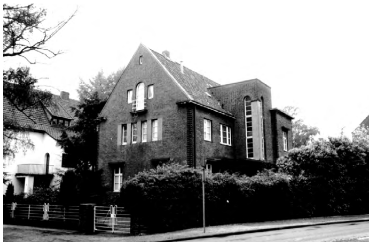
Abb. IV Gütersloh, Robert-Koch-Straße 5, Haus Falkenreck
