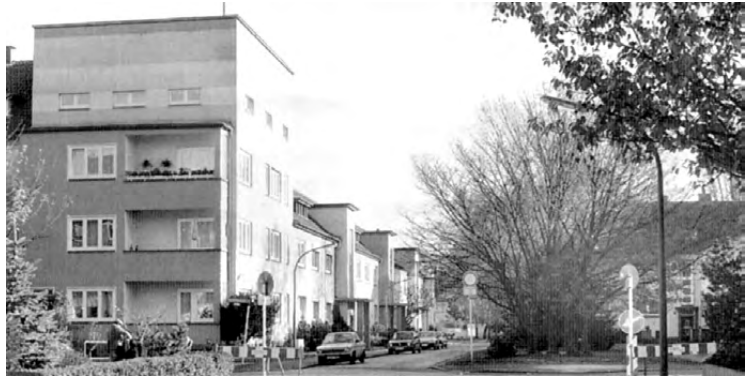
Abb. 67 Ansicht Niederhofener Straße / Reiner-Daelen-Straße
