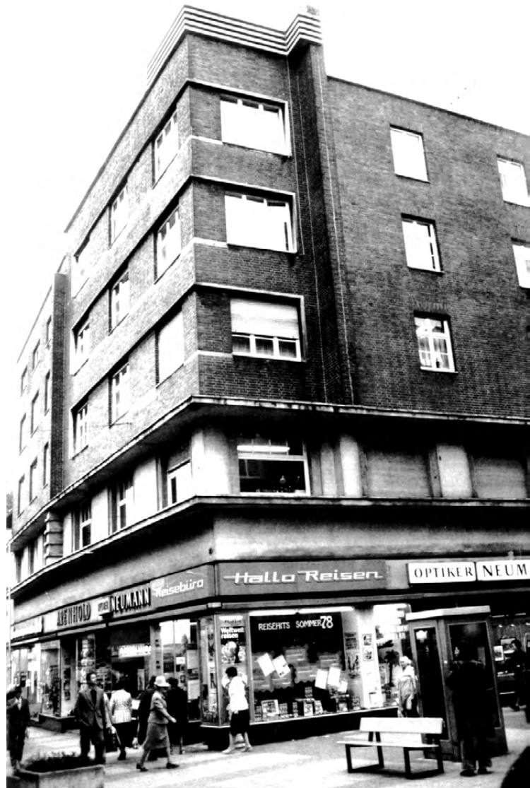
Abb. 80 Ansicht Hochstraße / Nienhofstraße
