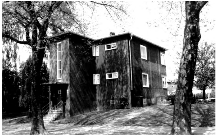
Abb. 75 Ansicht Marler Straße 8
