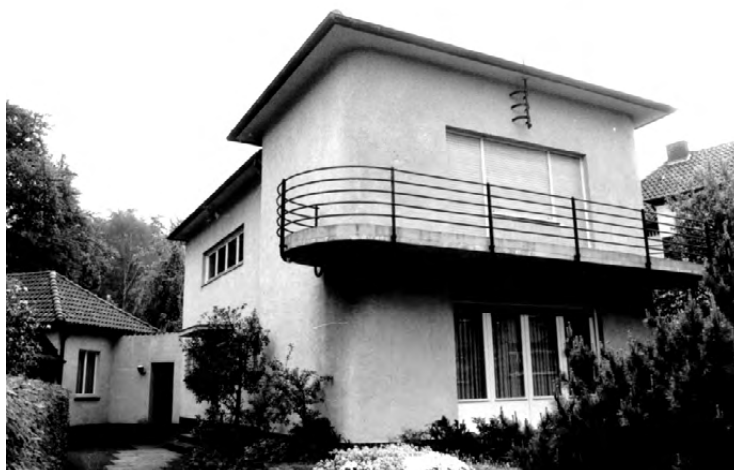
Abb. XXV Gütersloh, Dalkestraße 9, Haus Westerbarkey
