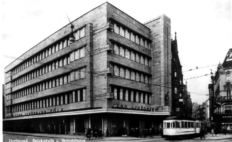
Abb. 62 Ansicht Kampstraße Ecke Brückstraße
