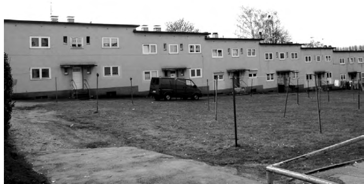
Abb. 119 Ansicht Ankerstraße 16a-24
