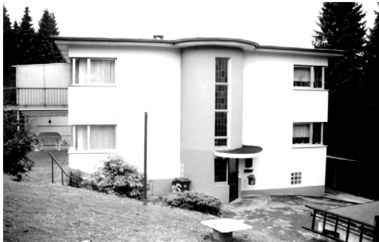
Abb. 81 Ansicht Milsper Straße
