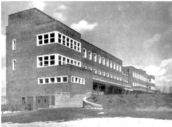
Abb. 6 Ansicht Eingangsfront (um 1930)
