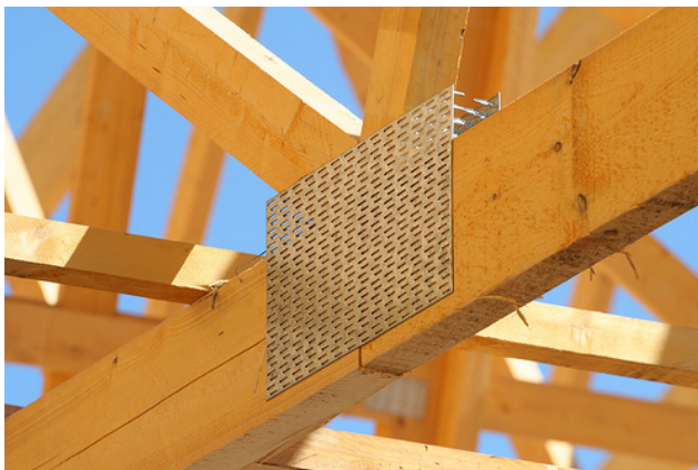
Bild 2-1 Fachwerkknoten mit Nagelplattenanschluss (Quelle: www.flickr.com )
