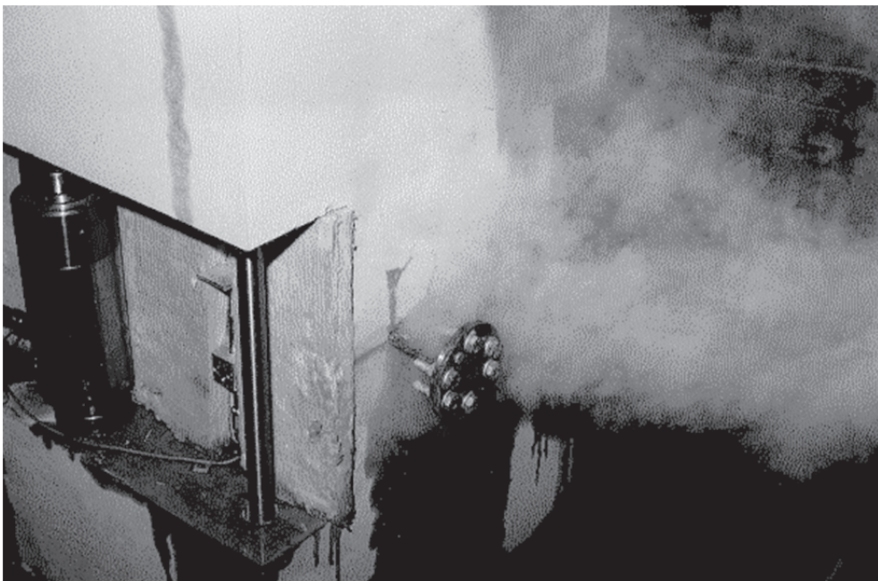
Abb. 2-42 Austritt von Dampf am Rissende bei Ramm [13]
