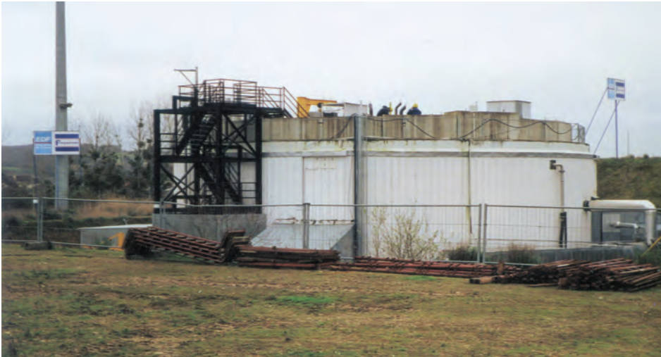
Abb. 2-34 Ansicht des Containments MAEVA
