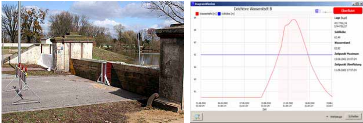
Abb. 6.16: Beispiel mobiler Hochwasserschutz Elemente und angepasster Diagrammdarstellung zur Gefährdungsanalyse
