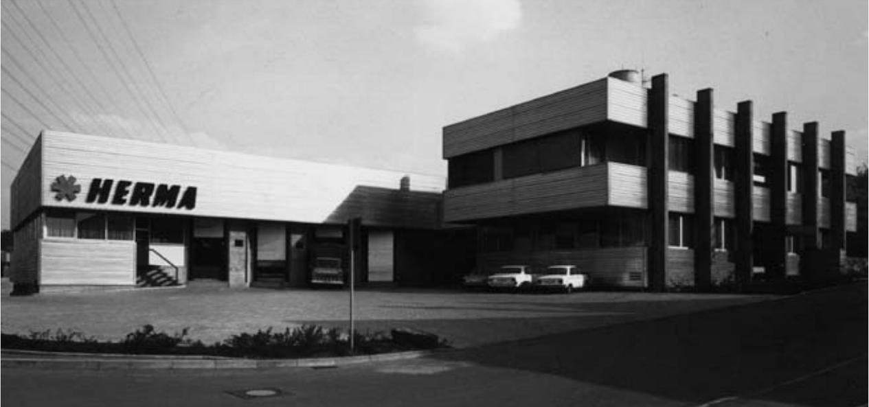
um eine Geschosshöhe nach unten versetzt. Der Haupteingang liegt am kleineren Wirtschaftshof hinter vier Rampen, die zur Be- und Entladung von Lastkraftwagen schräg nebeneinander angeordnet sind. Für den Betrieb ist neben den Ladestellen, die die Höhe des Erdgeschossniveaus im Inneren des Industriebaus vorgeben, ein kleiner Aufgang zum Büro der Versandmitarbeiter angelegt.
