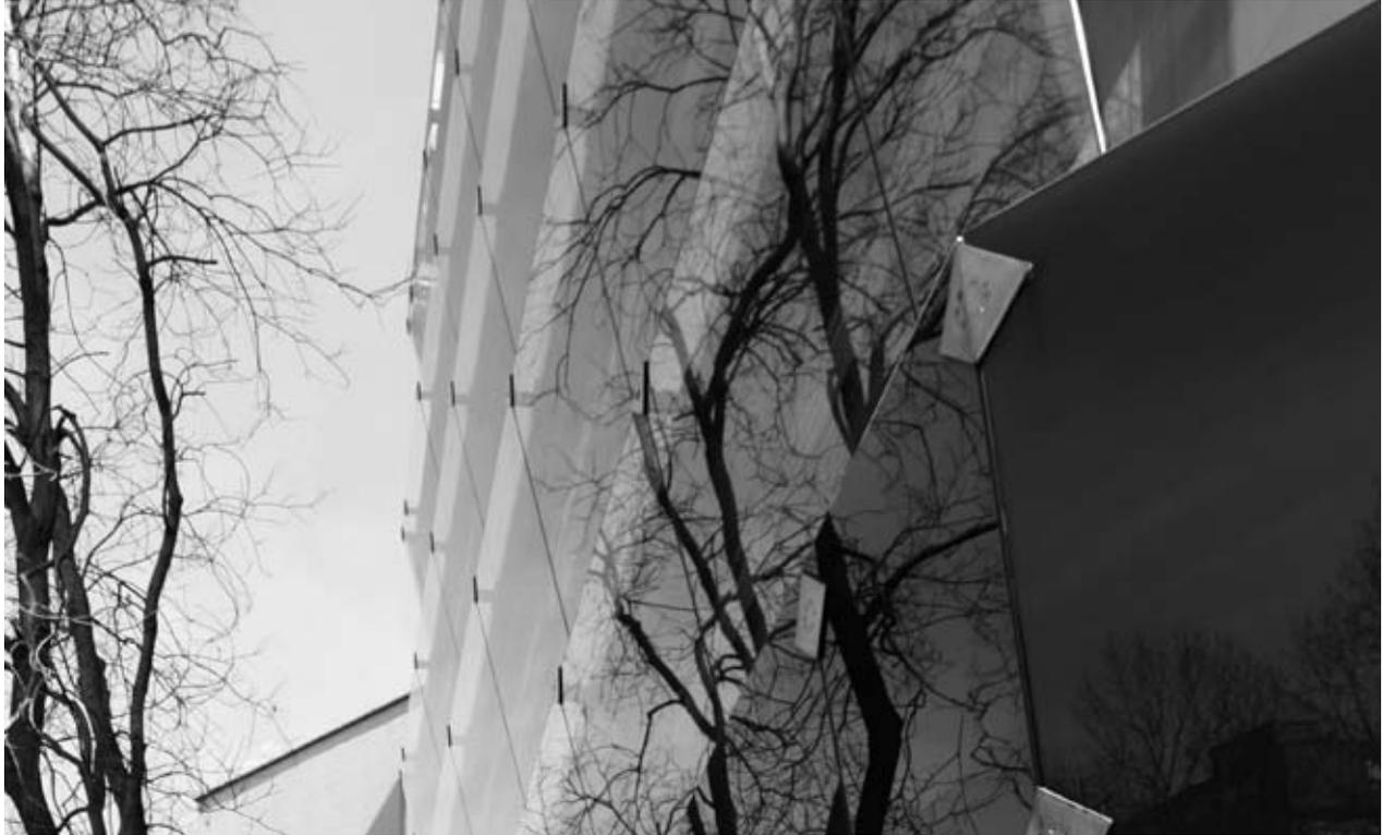
der Bewohner verändert wird und dabei eine weitere Dimension im Bauen eröffnet. Ihre verschiebbaren Elemente aus lichten Blechlamellen, die in einer Ebene vorgehängt sind, bilden einen membranhaft halbdurchlässigen Raumabschluss. Zudem ruft die Reflektion der Sonne auf den schrägen Oberflächen einen optischen Effekt, ein Flimmern, hervor, so dass die Front auch im Zustand der Ruhe noch eine gewisse Dynamik ausstrahlt.
