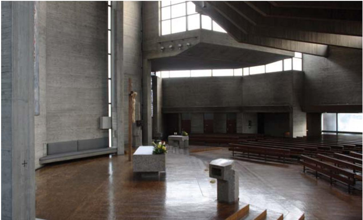
*Der Kirchenraum wird dominiert vom oberhalb des Altars zusammengeführten Fächer der Betonträger, die das Flachdach tragen. Über dem Knick befindet sich ein vertikal verglaster Versatz im Dach, durch den Licht zwischen den Balken hindurch zum Altar geführt wird.*
