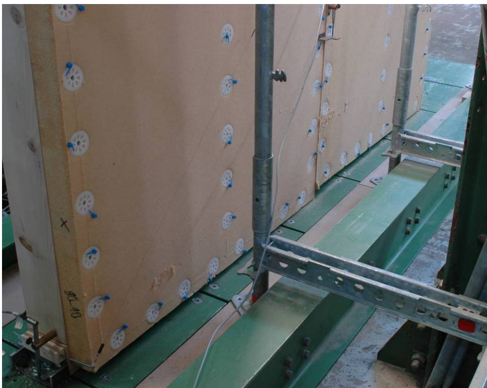
Bild 12-14 Typisches Versagensbild der Wandscheiben: Erreichen der Tragfähigkeit der Verbindung zwischen Beplankung und Unterkonstruktion
