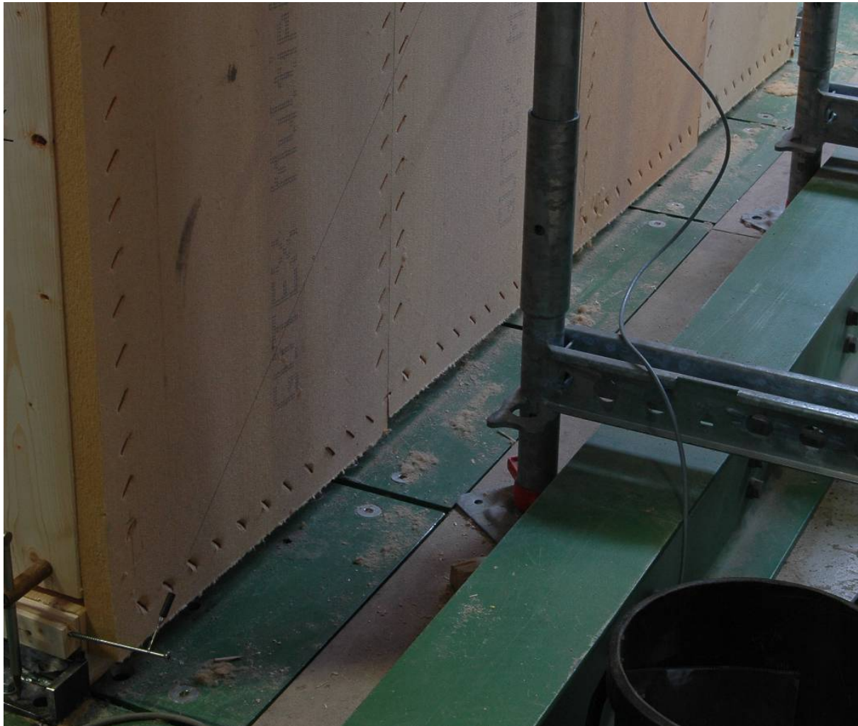
Bild 12-22 Versagensbild im Wandscheibenversuch mit vertikalen Beplankungsstößen auf den Innenrippen
