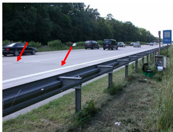
Bild 6: Ansicht der Messstelle (Blick Richtung Süden); die roten Pfeile markieren die Orte der Temperaturmessung in der Fahrbahndecke; rechts im Bild ist der Schutzkasten für die Datenerfassungseinheit und die Stromversorgung sowie der Mast mit den Sensoren für die Erfassung der Lufttemperatur und der relativen Luftfeuchte zu erkennen
