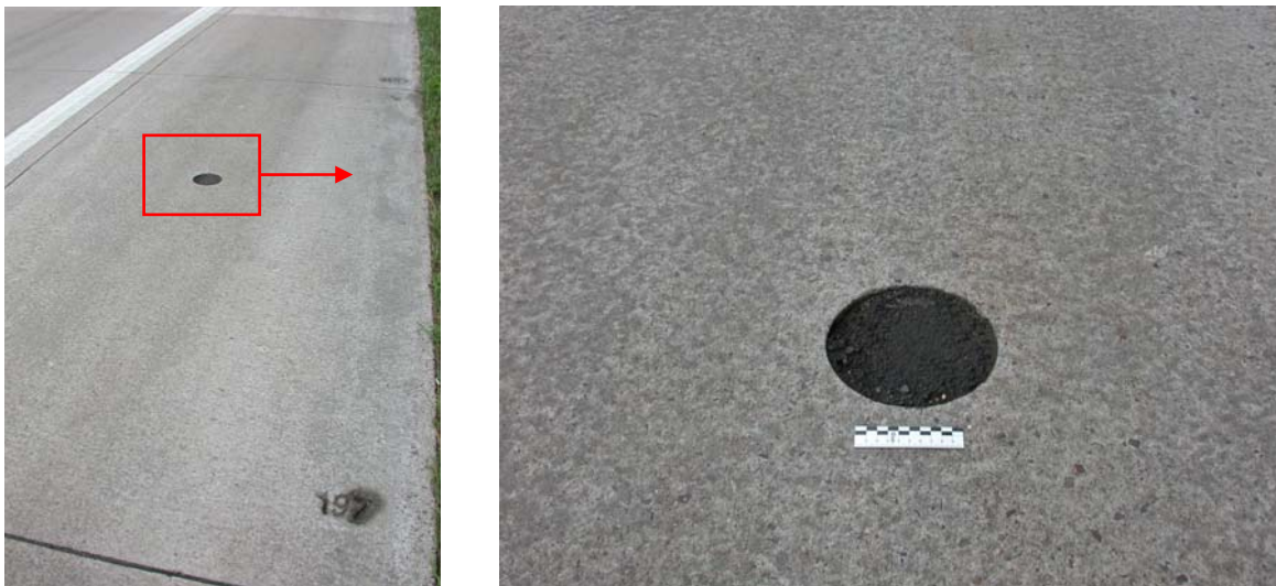
Bild 33: Zustand der Fahrbahndecke im Bereich der Entnahmestelle des Bohrkerns Nr. 17, beeinflusst durch Gewittereinwirkung während der Herstellung; Zeitraum nach der Herstellung bzw. Nutzungsdauer: 6 Jahre
