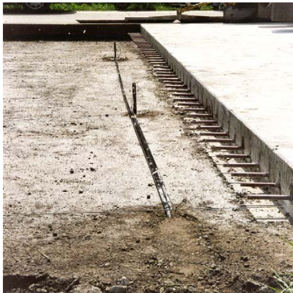
Bild 8: Einbau der Haltegestelle mit den Sensoren für die Temperaturmessung im rechten und mittleren Fahrstreifen, jeweils im Bereich der rechten Rollspur
