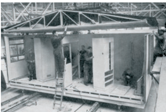
Abb. 1.09 Montage eines LUSTRON-Hauses
