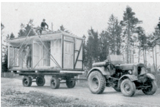
Abb. 1.57 Dornier-Haus, Transport zur Baustelle
