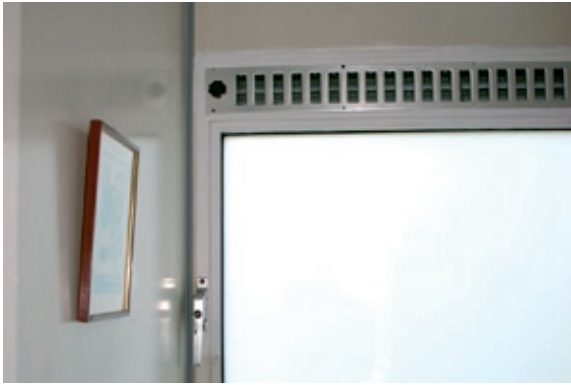
Abb. 2.23 und Abb. 2.24 Haus Wolters, Lüftungsöffnung am WC-Fenster und Türelement am Abstellraum
