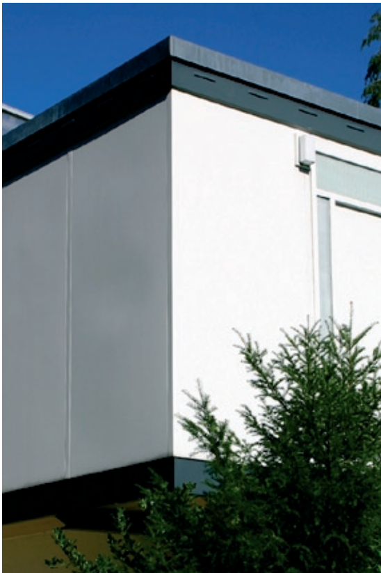
Abb. 1.21 HOESCH-Haus, Elementstöße
