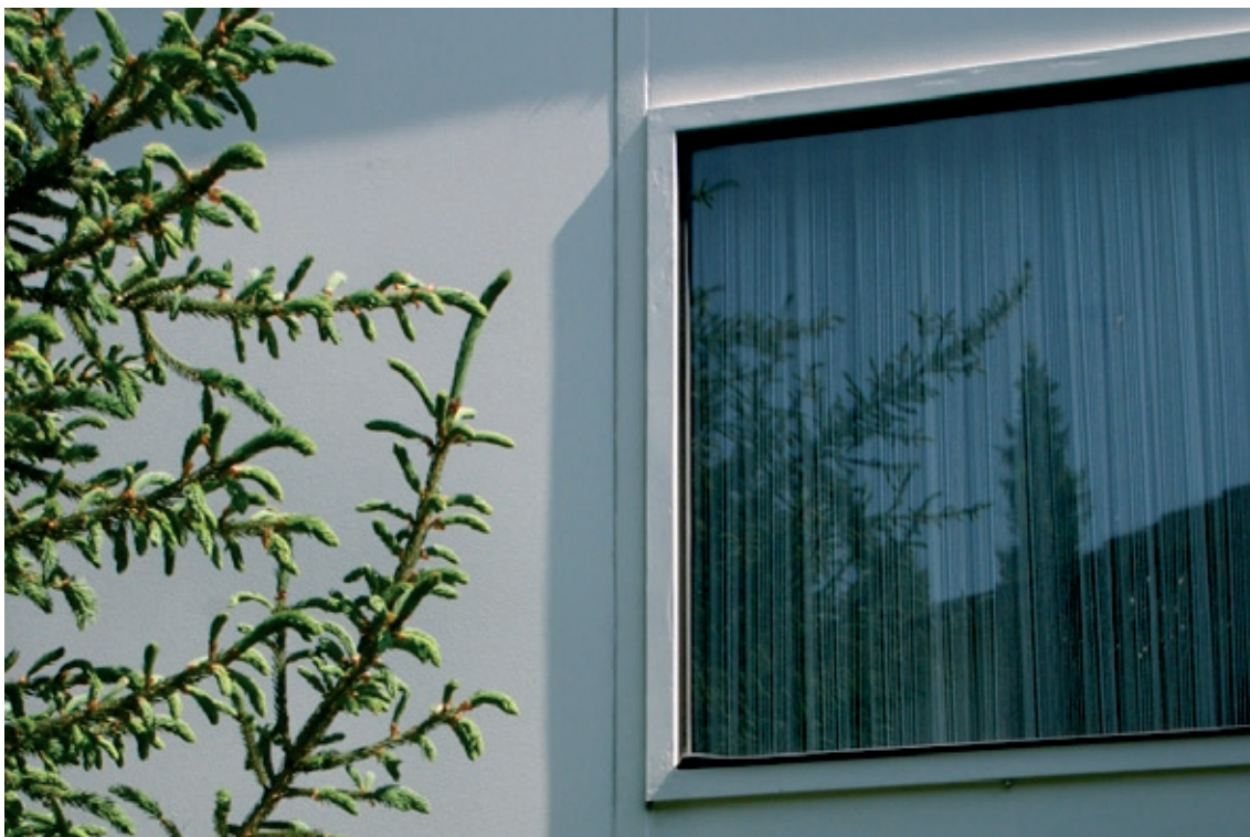
Abb. 2.22 Haus Wolters, Fenster im Wandelement
