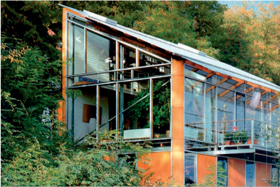
Abb. 1.13 Haus in Saarbrücken, Markus Ott
