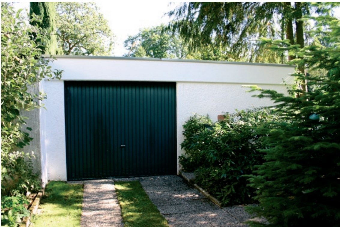
Abb. 3.27 Haus Wolters, Rückseite Garage
