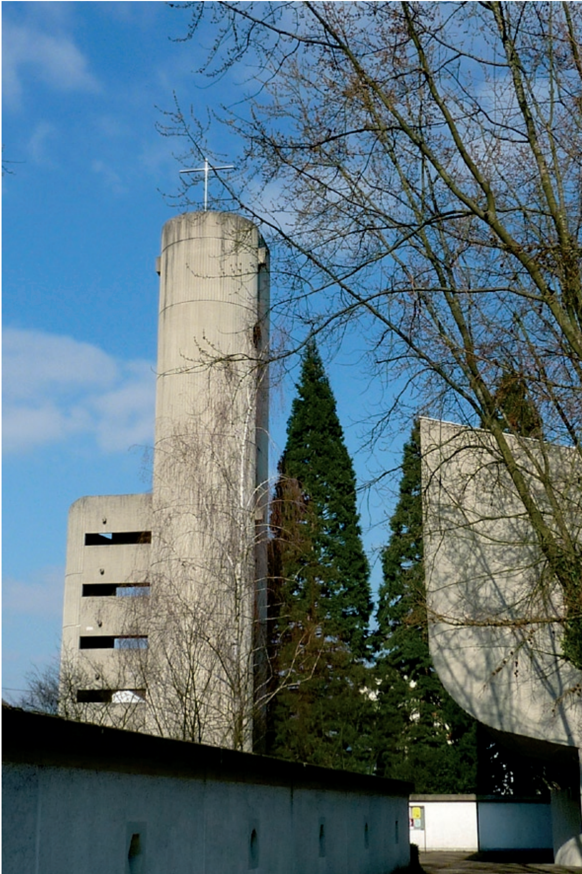
Abb. 4.06 Kirche St. Marien, Gaggenau, Zustand 2011
