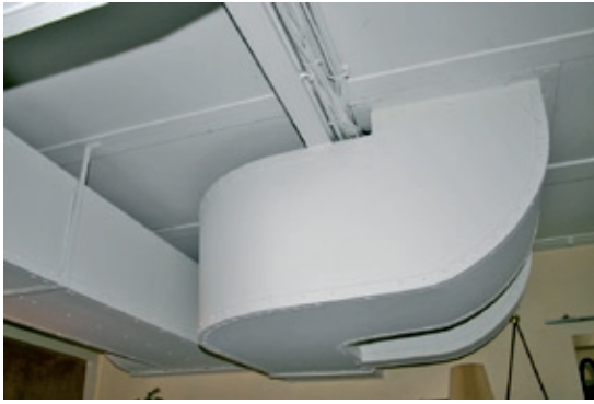
Abb. 3.21 und Abb. 3.22 Haus Wolters, Kanalführung Heizung
