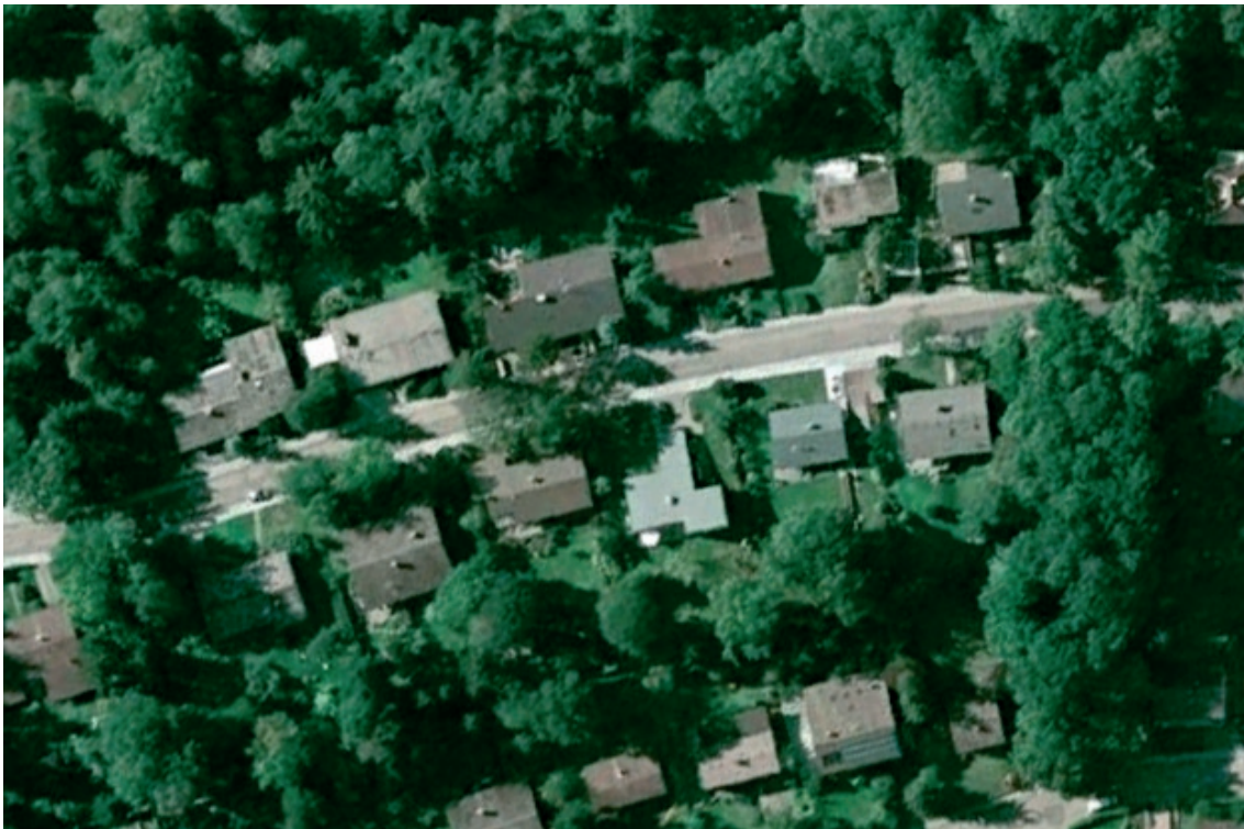
Abb. 3.10 Haus Wolters, Luftbild
