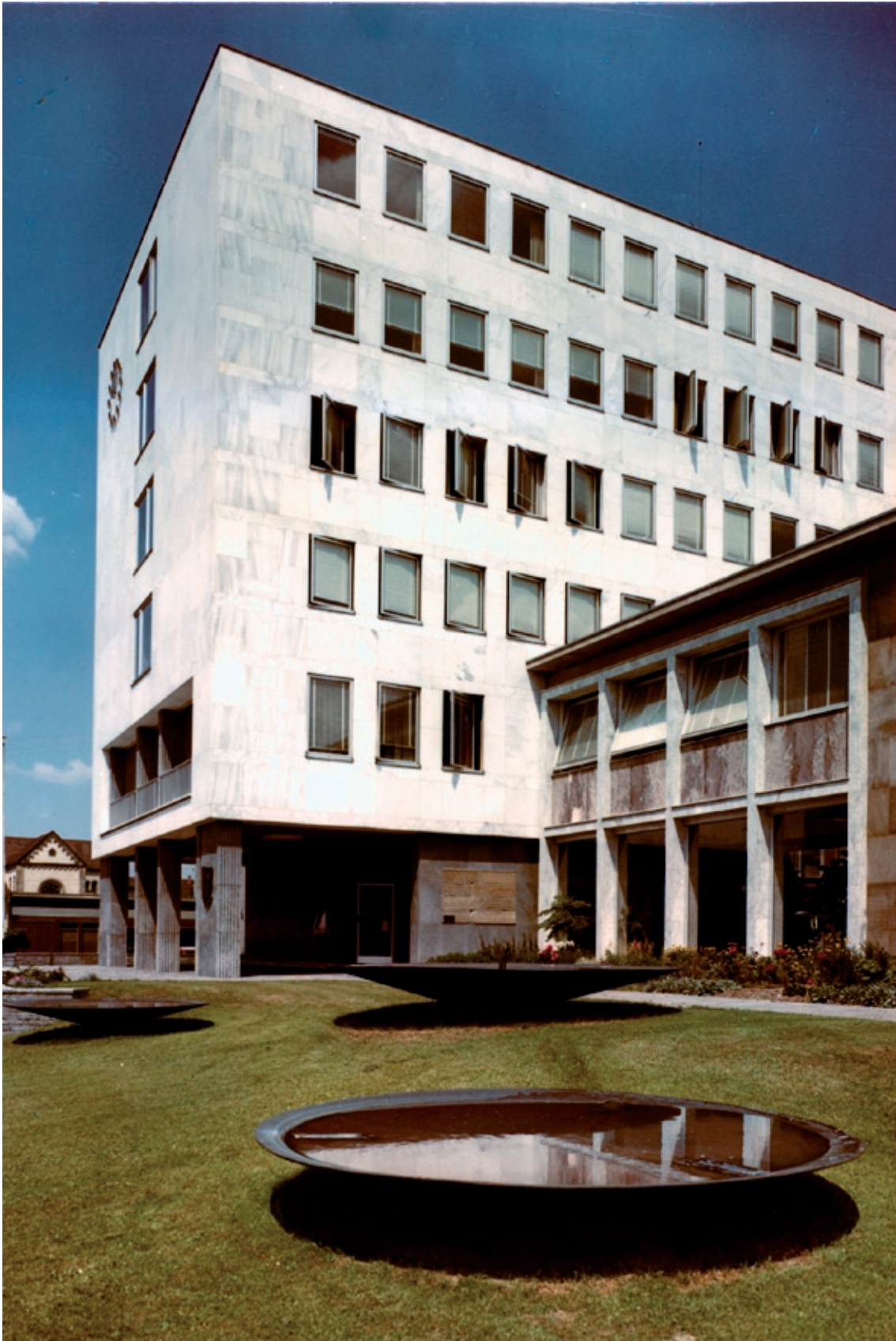
Abb. 4.04 Rathaus Gaggenu, Aufnahme Bauzeit
