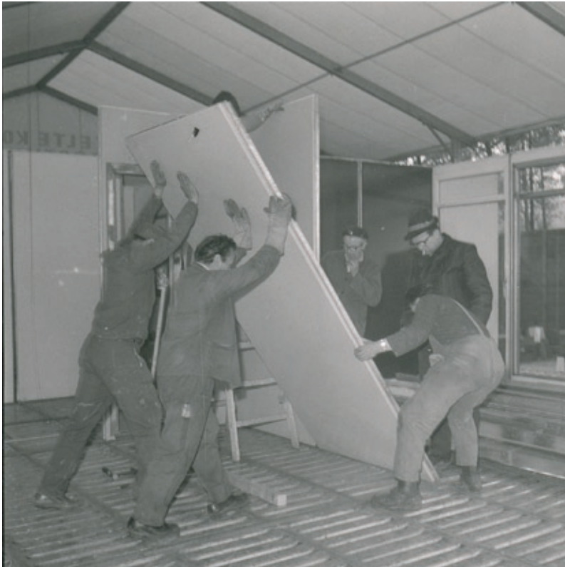
Abb. 3.08 Schutzzelt bei der Montage
