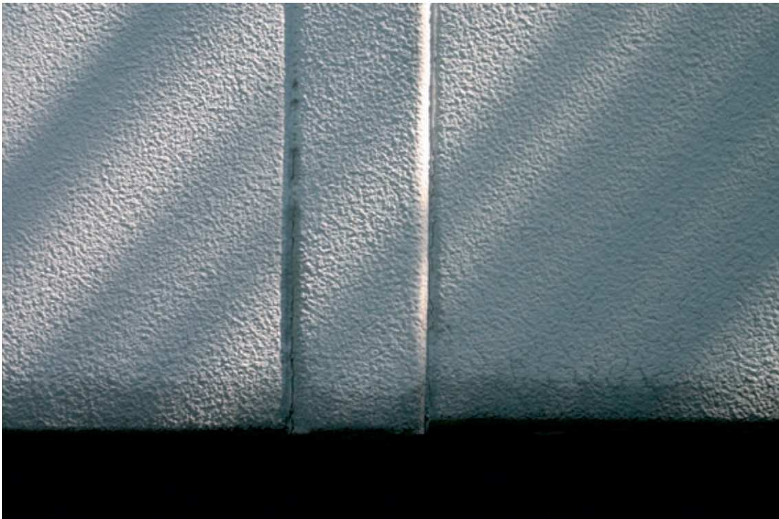
Abb. 4.01 Haus Wolters, Oberfläche Fassade
