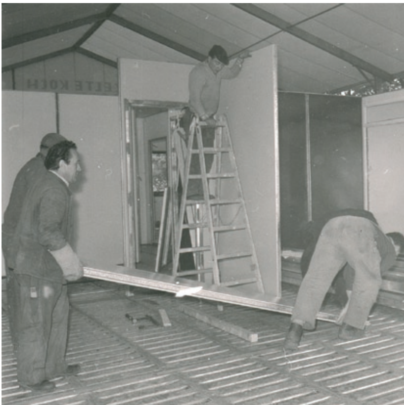
Abb. 3.09 Schutzzelt bei der Montage
