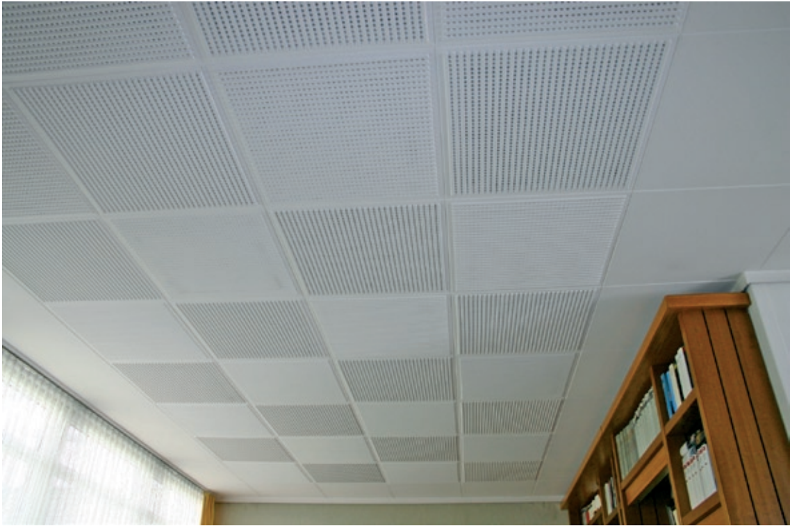
Abb. 6.16 Haus Wolters, Wohnzimmer, Detail abgehängte Decke
