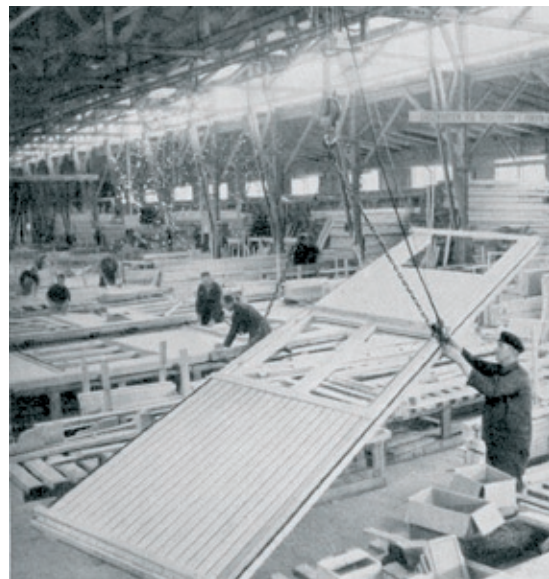
Abb. 1.45 LUSTRON Company, Montage der Bauteile im Werk
