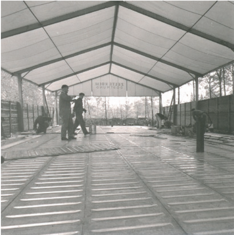
Abb. 3.06 Schutzzelt bei der Montage
