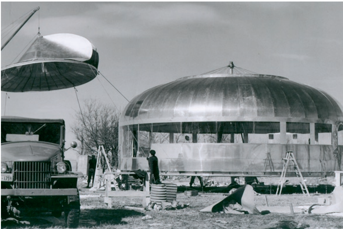
Abb. 1.28 DYNAMAXION House, Aufbau und Montage
