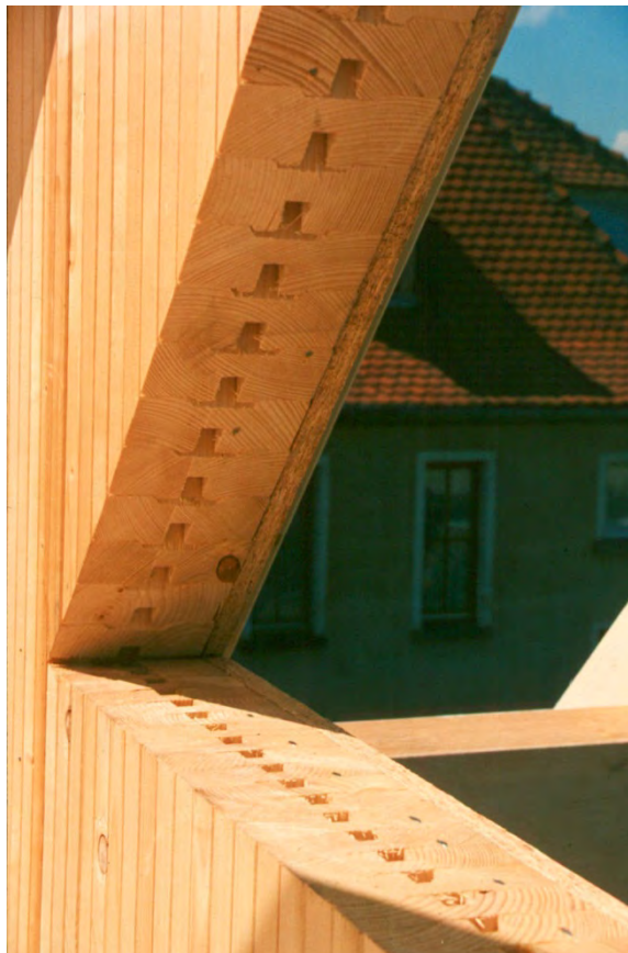
Abb. 2 Brettstapelwand
