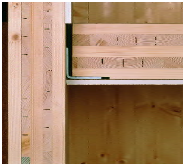
Abb. 3 Brettsperrholzwand und -decke
