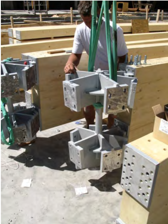
Abb. 10 Die einzelnen Elemente auf der Baustelle
