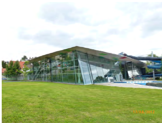
Abb. 1 Ansicht der Schwimmhalle
