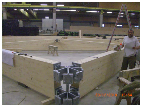
Abb. 12 Probezusammenbau eines Dreieckes
