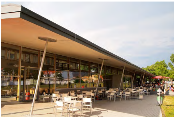
Abb. 1 Punktgestützte Decke, Mensa der Universität Bamberg
