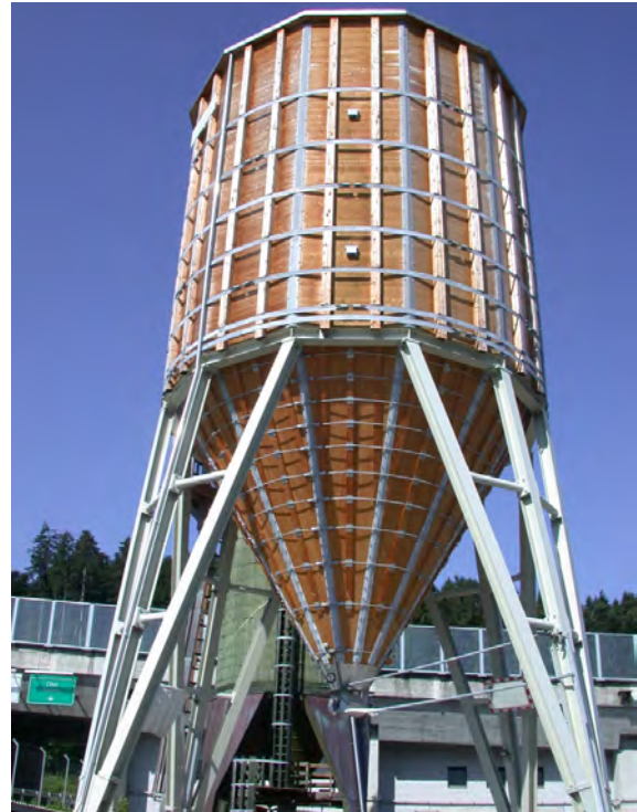
Abb. 15 Messsensoren an einem Salzsilo (© EMPA)
