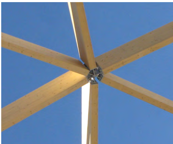
Abb. 20 Knoten im eingebauten Zustand
