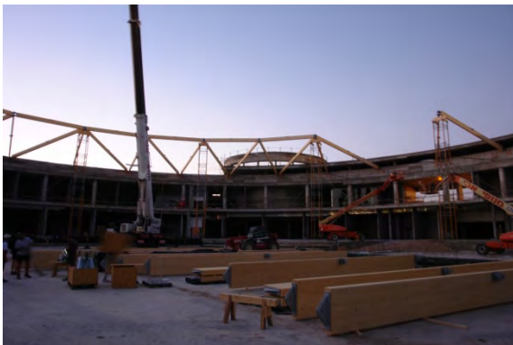
Abb. 17 Montagebeginn mit Hilfsunterstellungen
