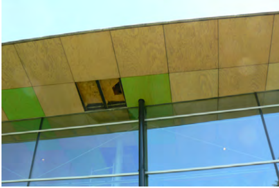
Abb. 6 Messstelle Nr. 1 im auskragenden Dachrand außerhalb der Glasfassade
