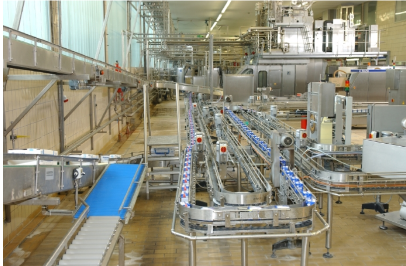
Abbildung 196: Tetra-Abfüllanlage in der Produktionshalle der Flüssigabfüllung [Bildquelle Humana Milchindustrie GmbH]
