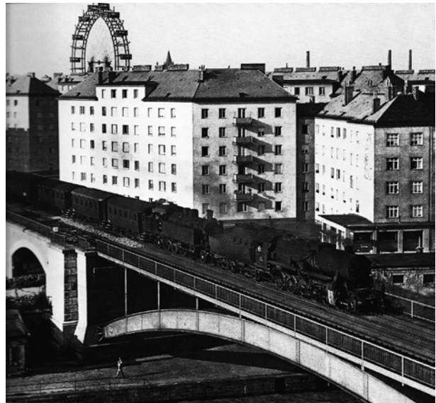
Abbildung 251 52.7412 und 77.263 auf der Donaukanalbrücke in Wien, 17. Juni 1959. 288
