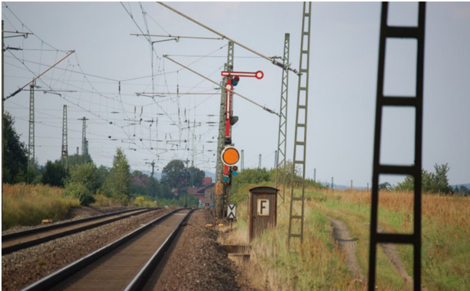
Abbildung 104 Einfahrt Bahnhof Breitengüßbach mit Formhauptsignal, das Hp0 zeigt, 2007. 125
