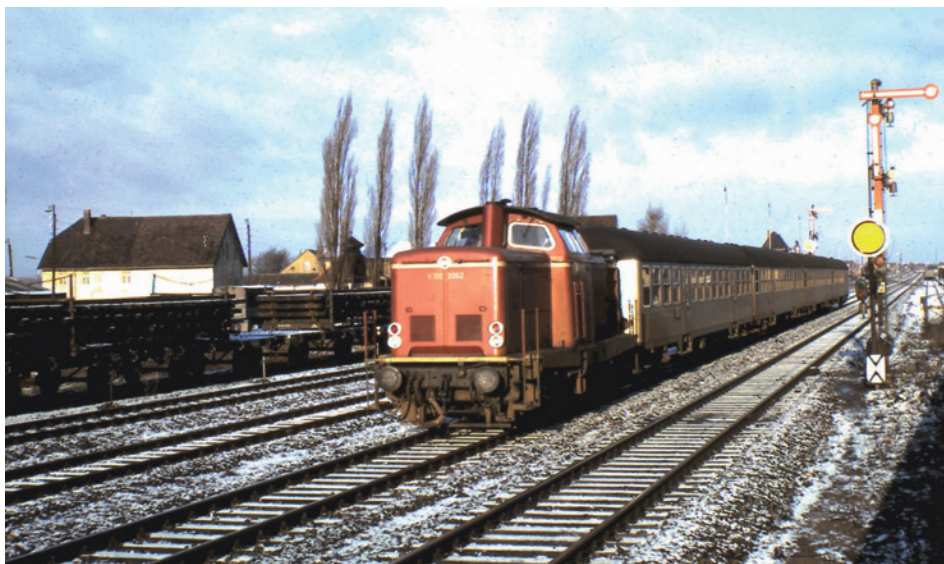
Abbildung 293 DB V 100 2042, gebaut 1962–65, Porta Westfalica, 1967. Runde Kanten, Lüfterschnurrbart. 337
