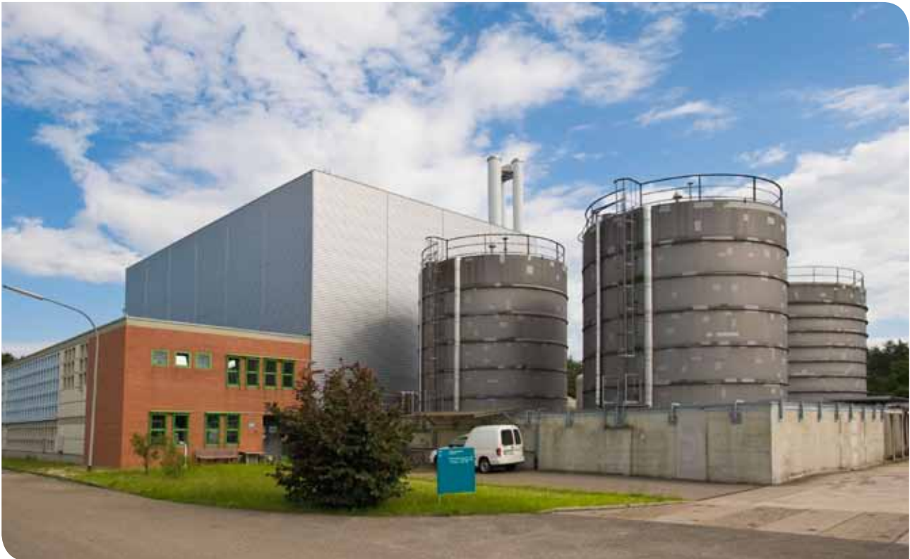
Ver- und Entsorgungsanlage TID
