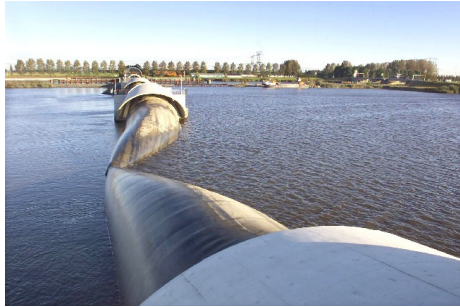
Bild 2: Ausbildung einer V-Kerbe als typisches Stabilitätsversagen eines Schlauchwehres
