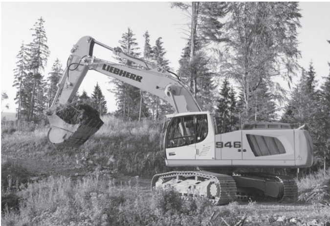
Abb. 1: Liebherr-Raupenbagger im Einsatz. „Heben der Ausrüstung sowie Schwenken des Oberwagens“
