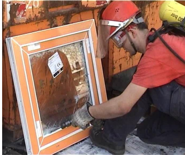
Abbildung 8-7: Meißelhammer an VSG – Scheibe
