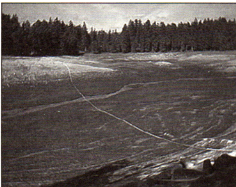
Abbildung 2: Blick von Osten über den trockenen Stauee
